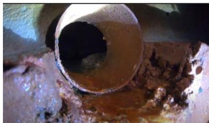
Imagen 8 Sedimentos en orificios de canal triangular
