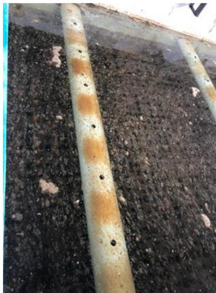
Imagen 7 Salida de agua sedimentada
