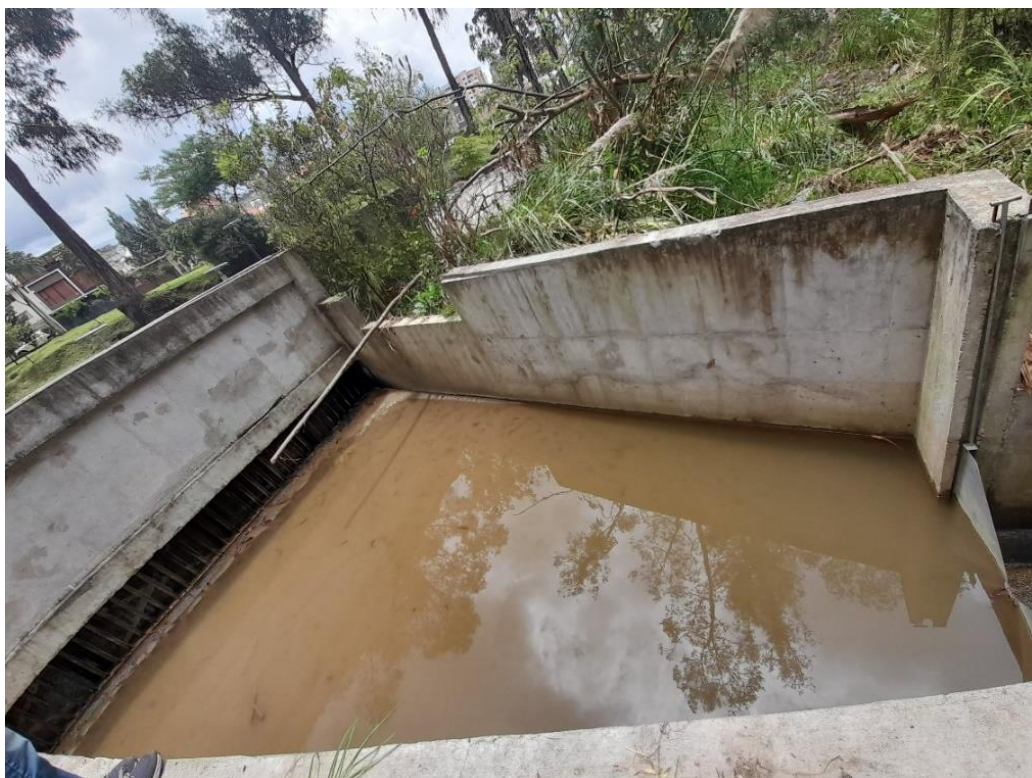
Figura 8. Rejillas de entrada, zona de disipación, transición y vertedero.
