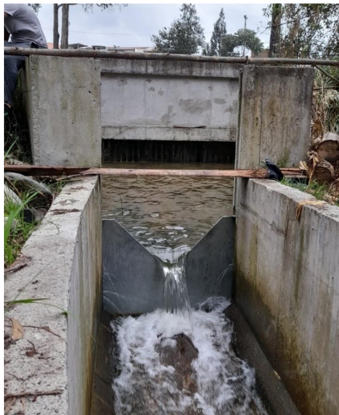
Figura 10. Vertedero triangular de pared delgada y canal.
