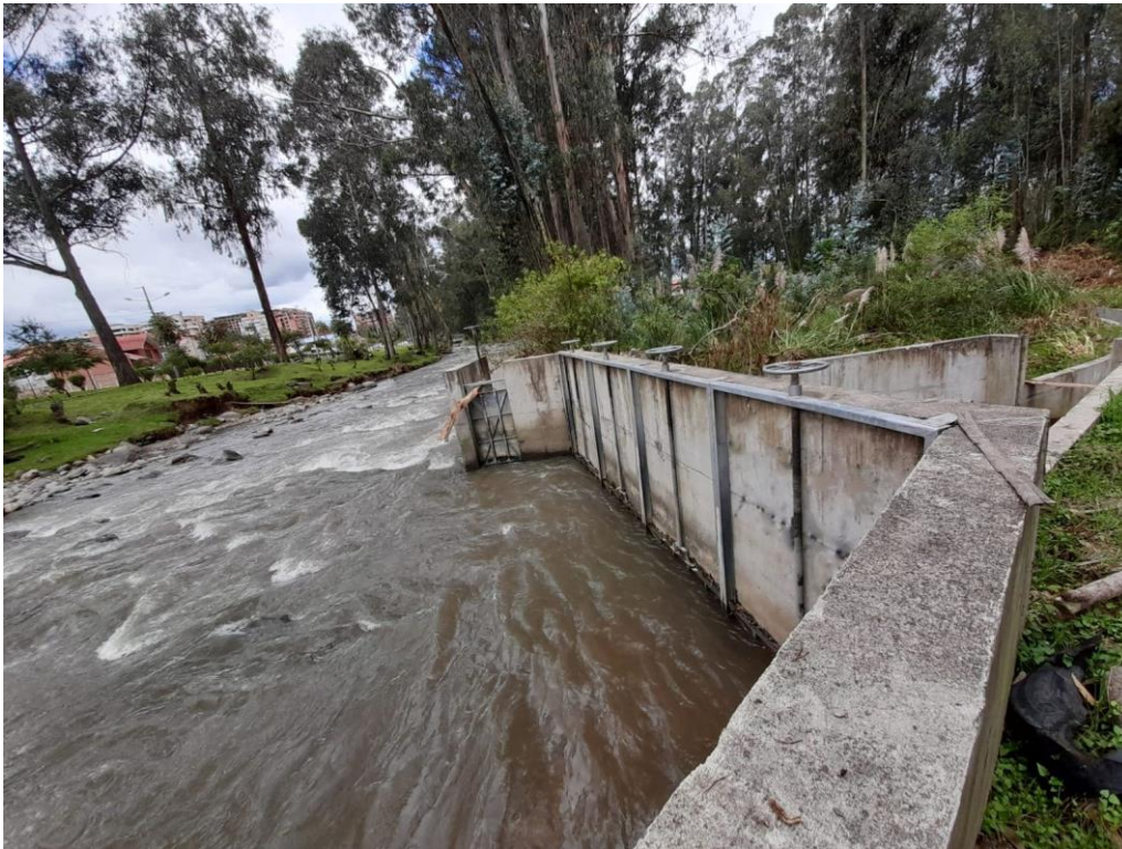
Figura 7. Entrada a la captación de derivación lateral.
