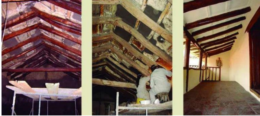
Figura 62. Imagen rehabilitación de cubrera y zona corredor (arquitecturayempresa.es, 2019)
