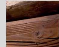
VIGA DE MADERA TERMOTRATADA BISELADA
