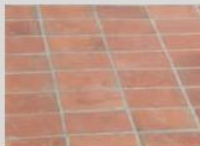
Piso de ladrillo pastelero con medidas 0,23 x 0,12 x 0,02 cm con acabado mate
