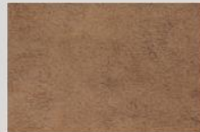
Acabado de pared empañetada con cal
