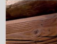
VIGA DE MADERA TERMOTRATADA BISELADA
