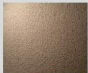
Empastado sobre muro de adobe y capa de pintura color hueso mate
