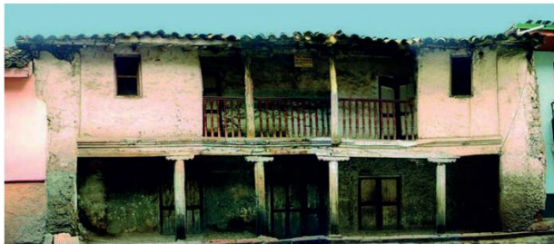
Figura 60. Fachada antes de intervención de la Casa de las Posadas (arquitecturayempresa.es, 2019)
