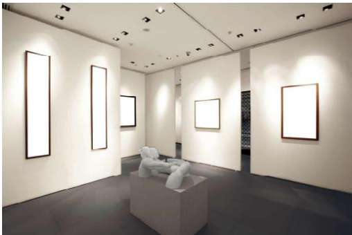
Figura 30. Iluminación LED empotrada y ajustable (Alcon Lighting ,2019)
