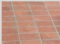
Piso de ladrillo pastelerio con medidas 0,23 x 0,12 x 0,02 cm con acabado mate
