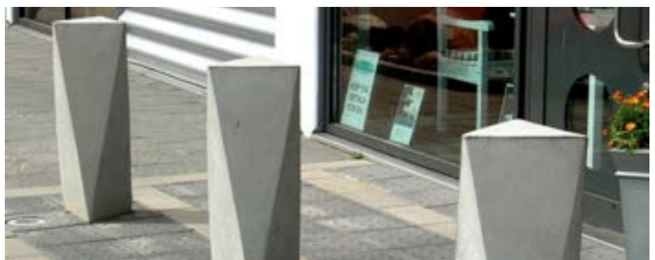
Figura 76: Bolardos fijo de hormigón armado.
