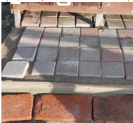
Figura 43: Detalle caminera zona duchas. Fuente: Propia
