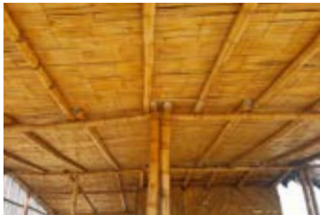
Figura 31: Detalle cielo raso. Fuente: Propia
