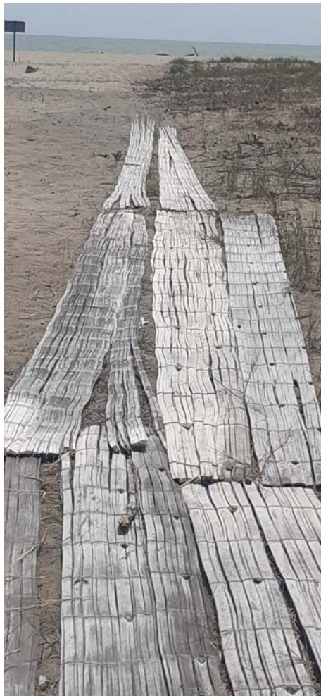
Figura 59: Caminera de caña chancada. Fuente: Propia
