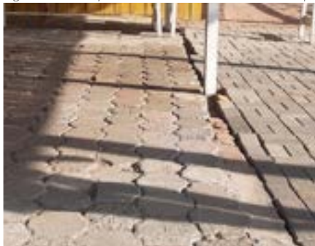
Figura 28: Detalle piso con adocreto. Fuente: Propia
