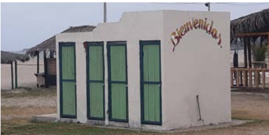
Figura 41: Bloque de duchas más elaborado con ladrillo y cemento.
