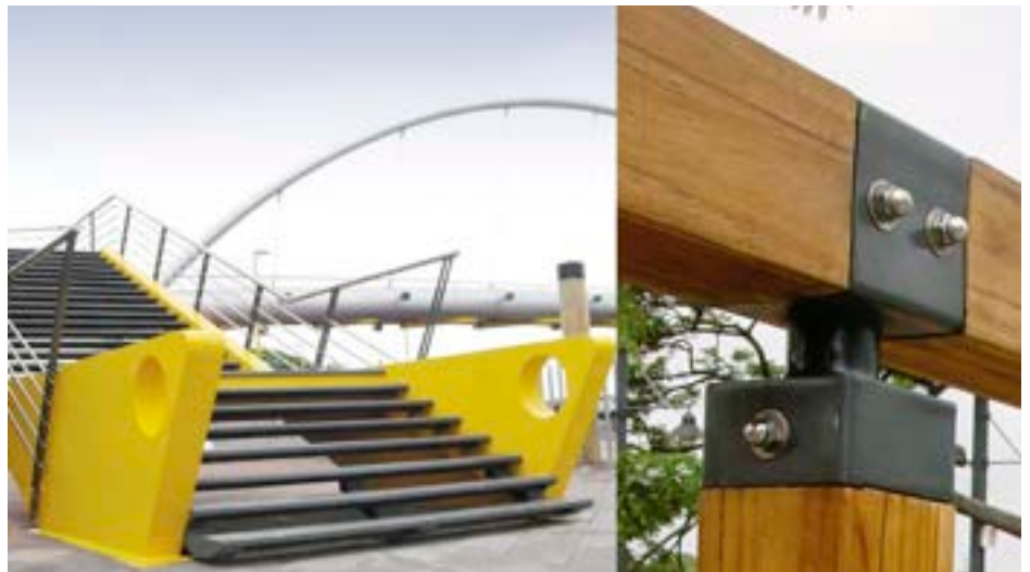
Figura 89: Escaleras y detalle de unión de pasamanos.
