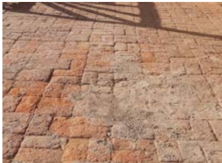
Figura 27: Detalle piso con ladrillo. Fuente: Propia
