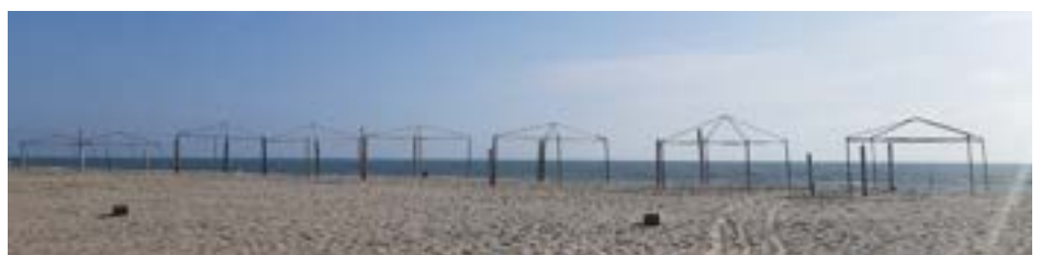
Figura 47: Estructuras armadas de los parasoles a lo largo de la playa.
