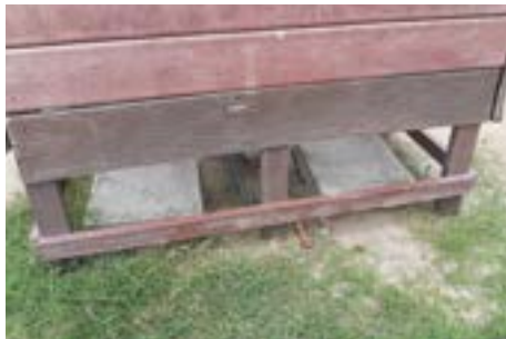
Figura 42: Detalle piso vestidores. Fuente: Propia
