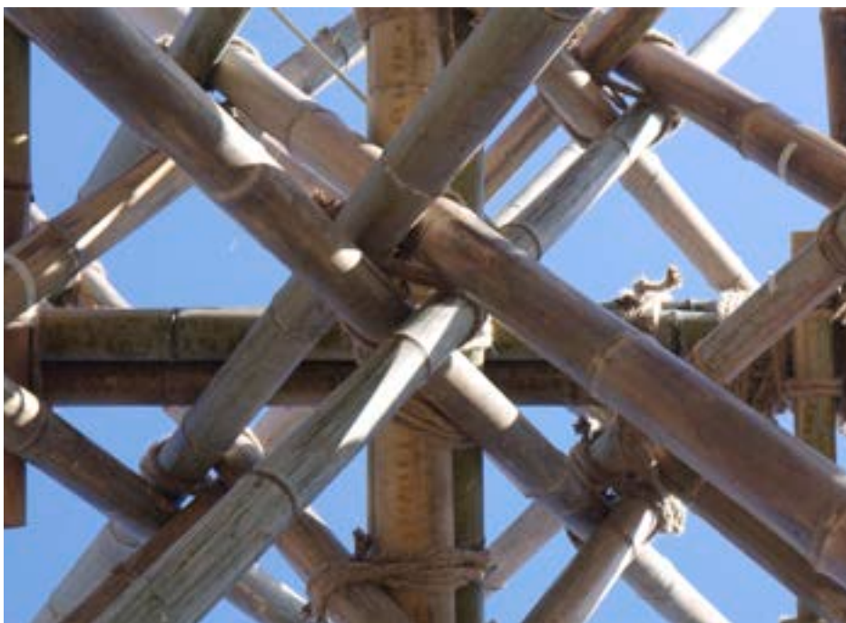
Figura 103 : Detalle colocación del bambú en pabellón.
