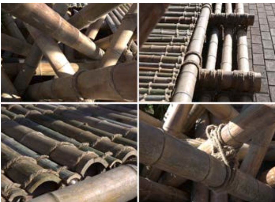
Figura 104 : Detalles constructivos del pabellón de bambú.
