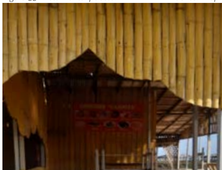
Figura 34: Detalle de faldón. Fuente: Propia
