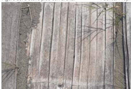
Figura 30: Detalle piso con caña chancada. Fuente:
