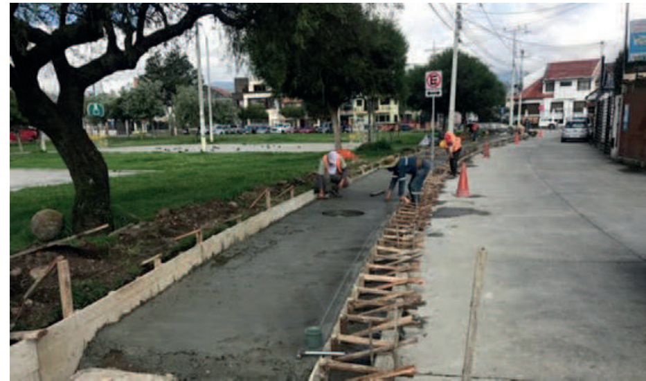
Figura 4.1.2 :Fundición de parte de las aceras en la ciudadela Kennedy. Elaboración: obras Públicas Municipio, Cuenca, Ecuador, 2021.
