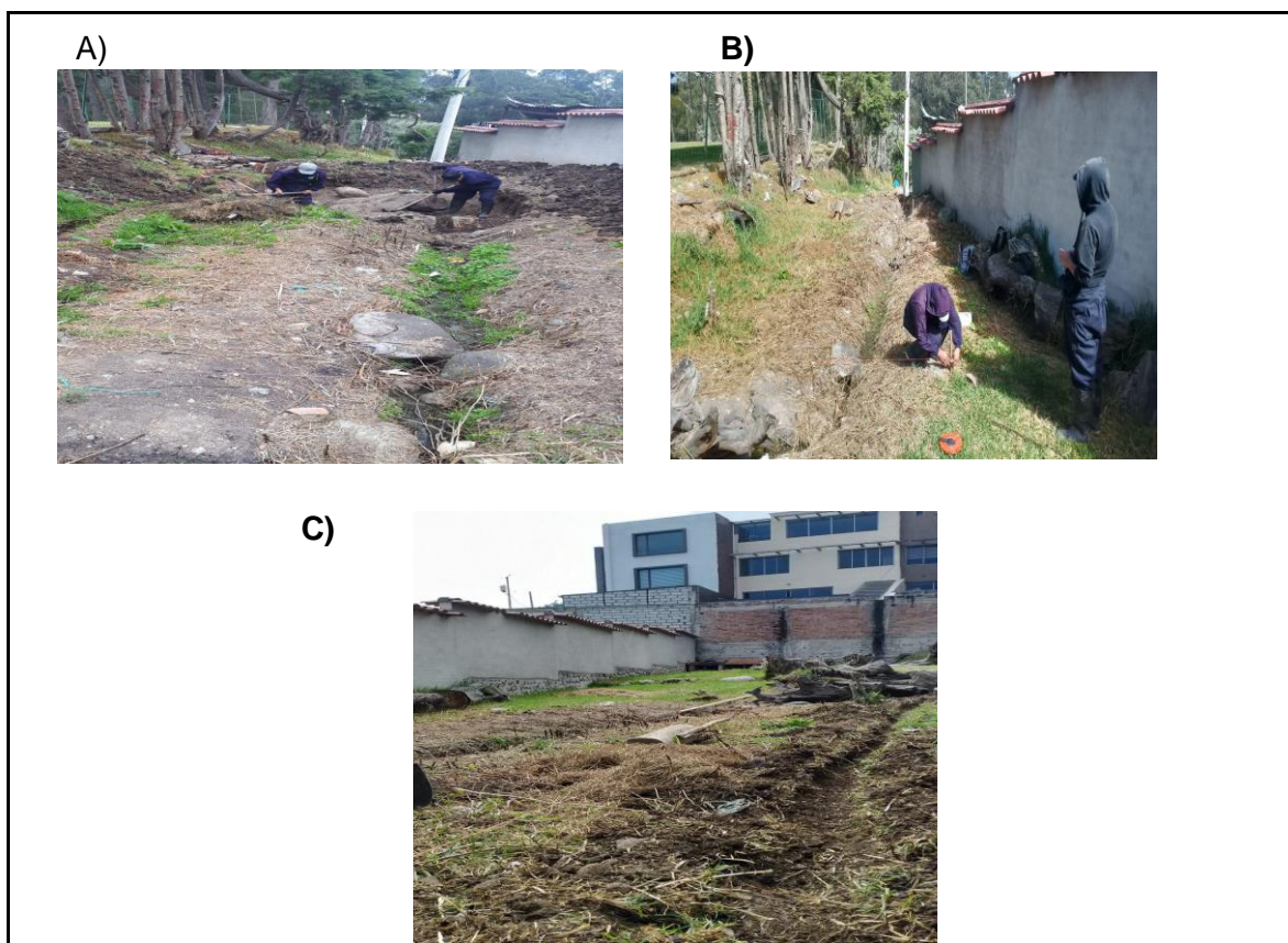
Figura 7. Delimitación y adecuación del área: A) Limpieza y desmote del sitio. B) Trazado del área de implantación del proyecto. C) Redirección del cauce actual del agua.
