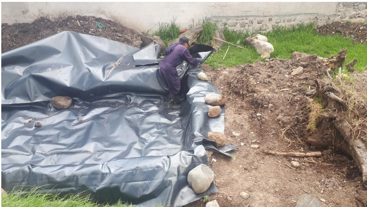
Anexo L. Colocación de geomembrana.
