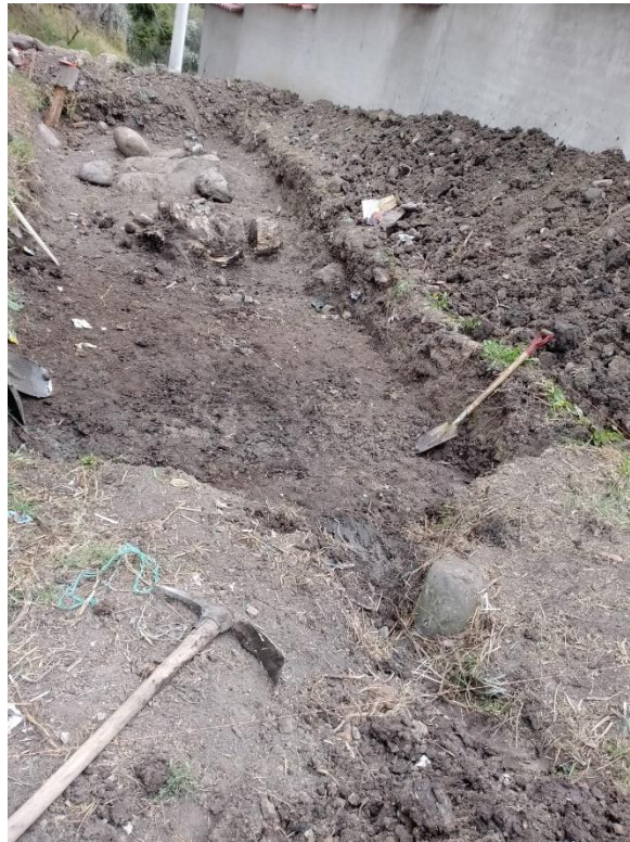
Anexo H. Labores de construcción.
