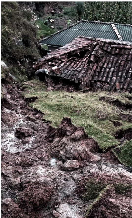
Figura 15: Deslizamiento, Hundimiento - Nabón Fuente: https://www.facebook.com/Azuay24/photos/pcb.479435230139062/479435123472406/
