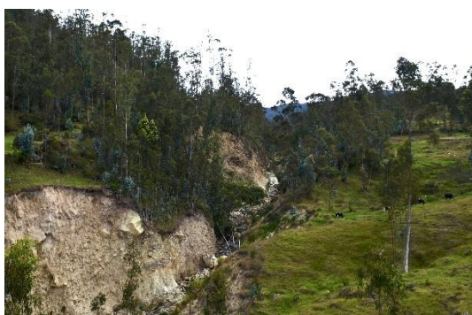
Figura 38: Deslizamiento D2 Fuente: Propia
