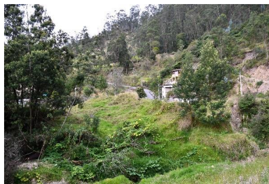
Figura 40: Deslizamiento D4 Fuente: Propia
