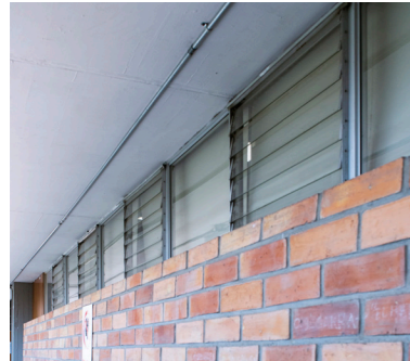
IMAGEN 31 Detalle de ventanas en aulas bloque E2 primera planta alta.
