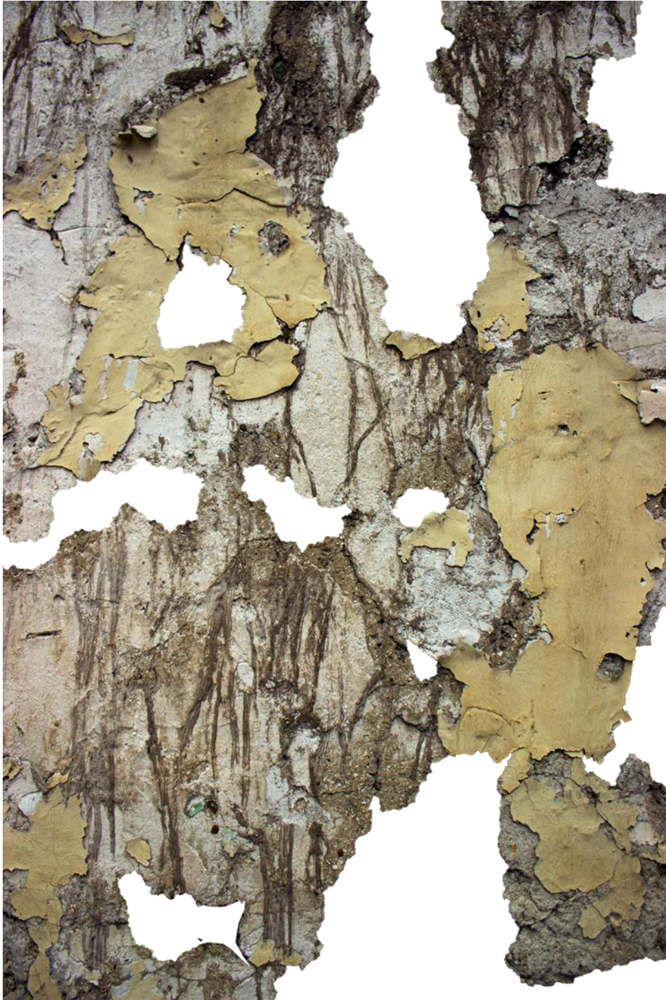
Fotografía 1. Fragmento de la fachada de una edificación patrimonial.
