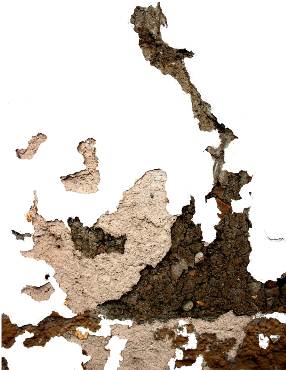
Fotografía 3. Fragmento de la fachada de una edificación patrimonial.
