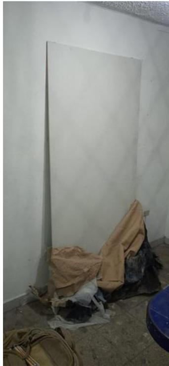
Imagen 18. Plancha de gypsum cubierta en la parte inferior con un telar de yute, un plástico de protección negro y fundas de saco de cemento (elaboración propia).
