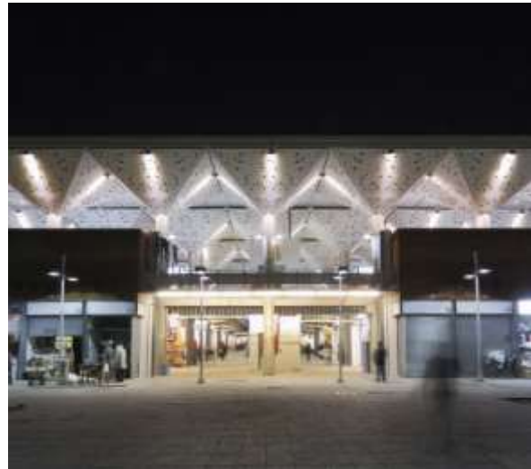
Figura 22: Mercado Tirso de Molina, Fotografía: Mutis P.(2011), Recuperado de: plataformaarquitectura.cl
