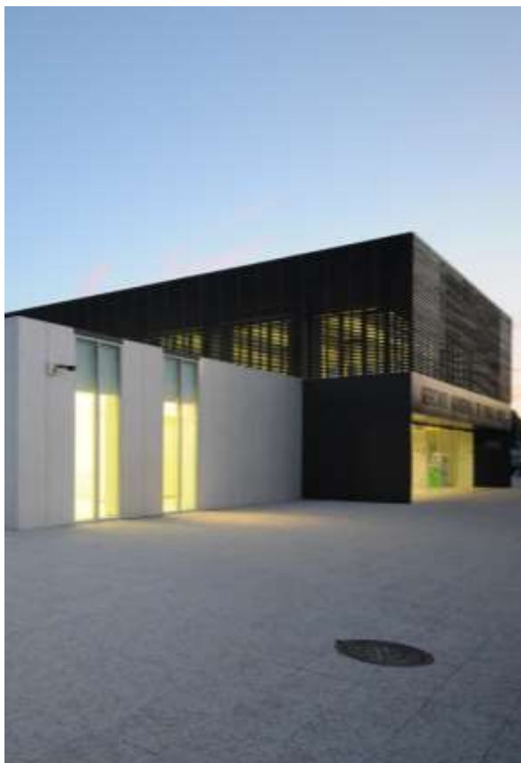
Figura 18: Mercado Municipal de Pinhal Novo, Fotografía: Costa J. & Sila T. (2018), Recuperado de plataformaarquitectura.cl
