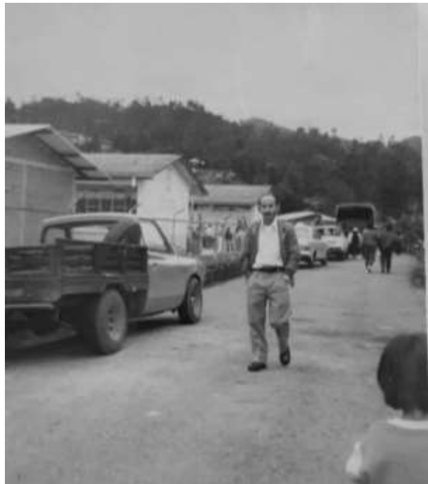
Figura 4: Entrada a la Escuela José Peralta, Fotografía: Quito M. (1985)
