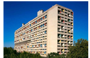
Figura 05. Unidad de Habitación de Marsella. Francia. Le Corbusier. 1952.
