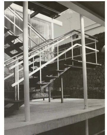
Figura 30. Detalle Escalera Casa Chérrez. Ecuador. Oswaldo de la Torre. 1964.
