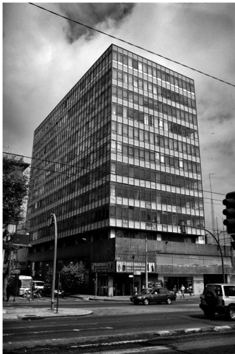
Figura 38. Edificio La Previsora Norte. Ecuador. Jaime Dávalos. 1964.
