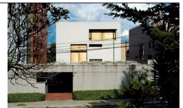
Figura 04. Edificio San Roque. Ecuador. Ribadeneira y Carrión. 2012.
