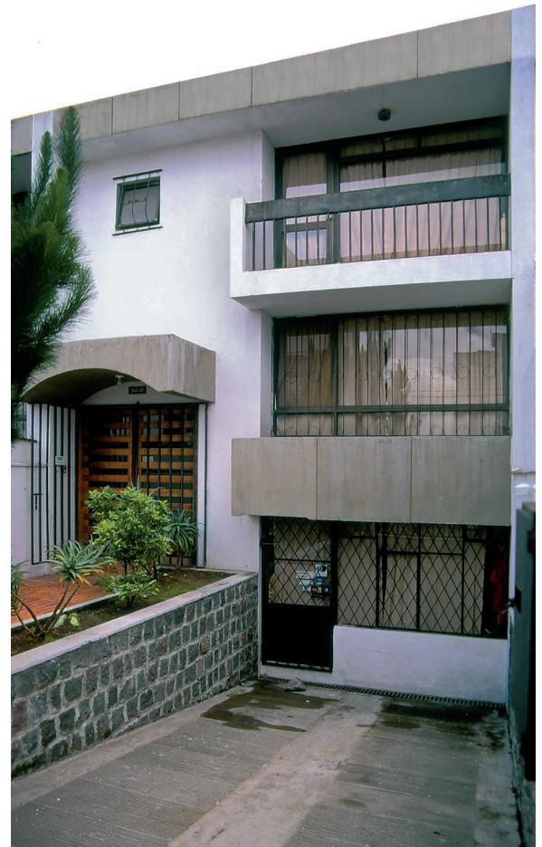
Figura 49. Fachada frontal vivienda
