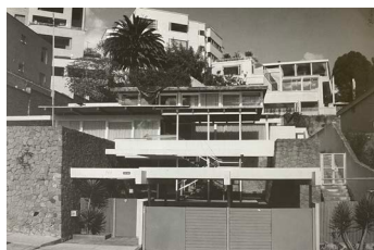
Figura 31. Casa Chérrez. Ecuador. Oswaldo de la Torre. 1964.
