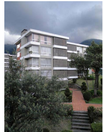
Figura 51. Conjunto Habitacional la Granja. Ecuador. Sergio Larraín y Ernesto Guevara. 1974-1980.
