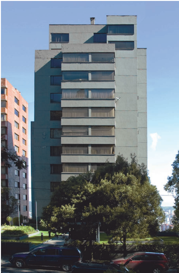
Figura 57. Relación entre edificio y retro frontal. 2012.
