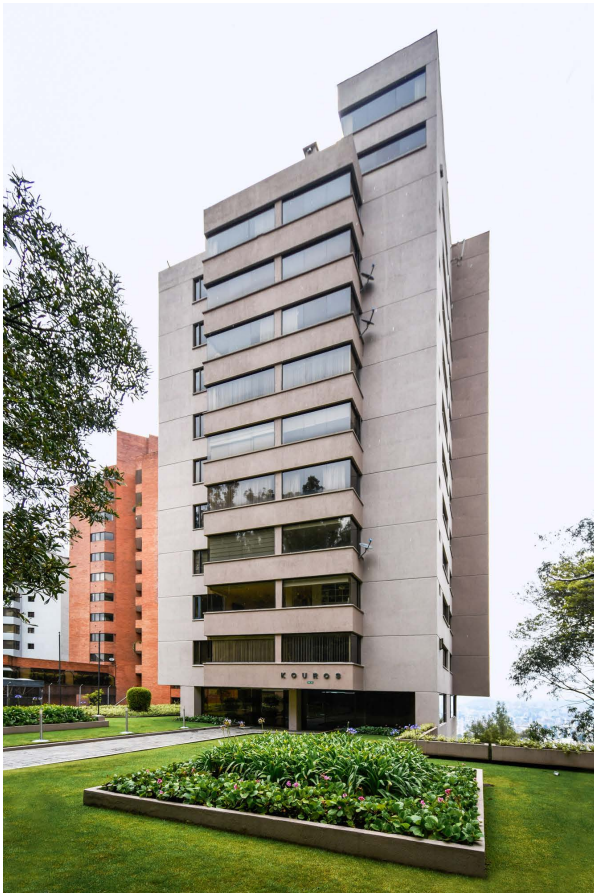
Figura 55. Fachada frontal y área verde. 2022.
