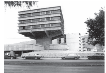
Figura 23. Edificio CIESPAL. Ecuador. Milton Barragán. 1978.
