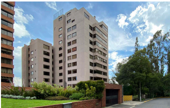
Figura 51. Edificio Kouros y su contexto
