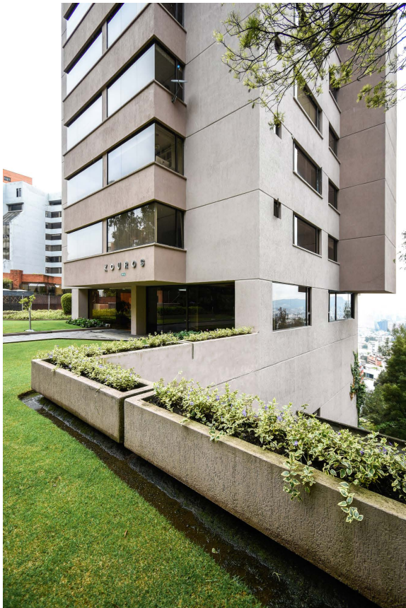
Figura 61. Fachada frontal y área verde. 2022.
