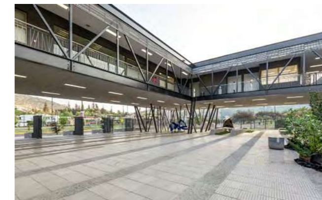
Figura 3.29: Colectividad de columnas en Centro Cultural El Tranque Fuente: Juan Francisco Vargas (2017).
