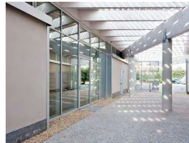
Figura 3.32: Pasarela peatonal cubierta del Centro Cultural "Le Creste" Fuente: Andrea Bosio (2015).
