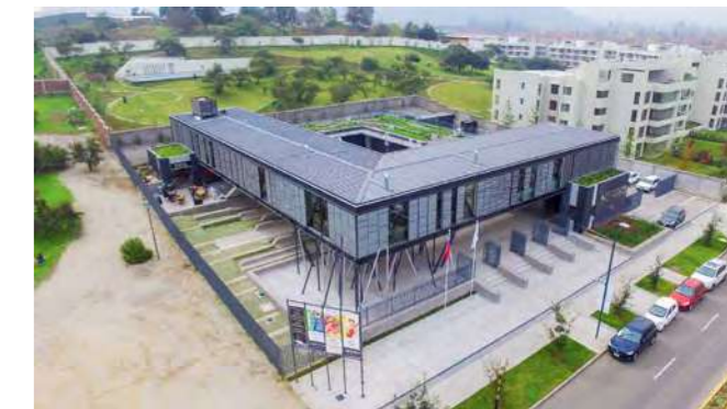
Figura 3.24: Vista aérea del Centro Cultural El Tranque Fuente: Juan Francisco Vargas (2017).
