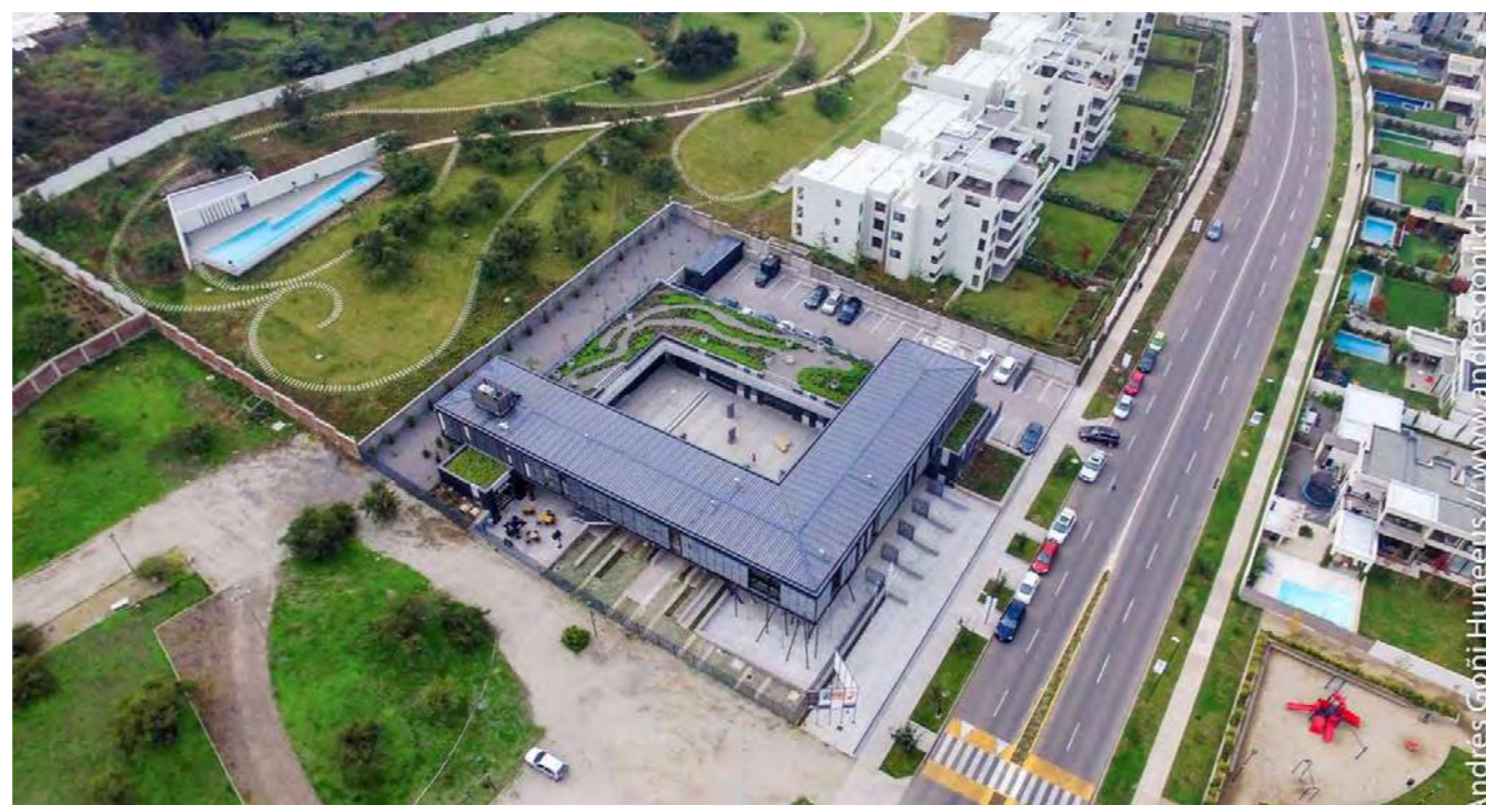
Figura 3.23: Emplazamiento del Centro Cultural El Tranque Fuente: Juan Francisco Vargas (2017).
