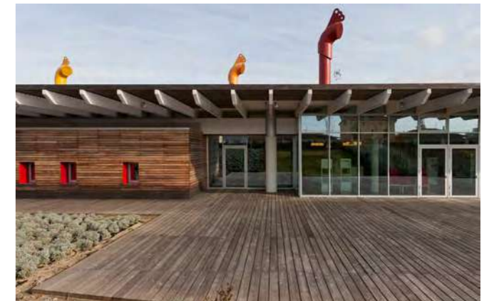
Figura 3.34: Sistema de refrigeración del Centro Cultural "Le Creste" Fuente: Andrea Bosio (2015).
