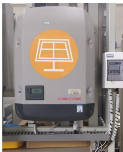
Figura 4.4: Inversor FRONIUS conectado a paneles policristalinos móviles de 1 y 2 ejes.
