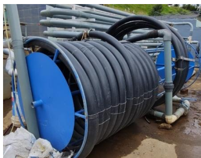
Ilustración 3 FLOCULADOR TUBULAR HELICOIDAL ARMADO ACTUALMENTE EN SITIO
