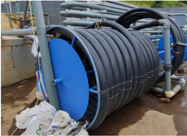
Ilustración 6 SISTEMA PILOTO DE FLOCULADOR HELICOIDAL ARMADO EN SITIO
