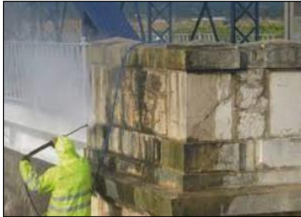
Imagen 163 Lavado a presión con chorro de agua Fuente: (Helene & Pereira, 2003)
