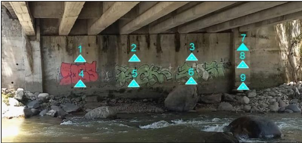
Imagen 119 Ubicación de pruebas de carbonatación en estribo
