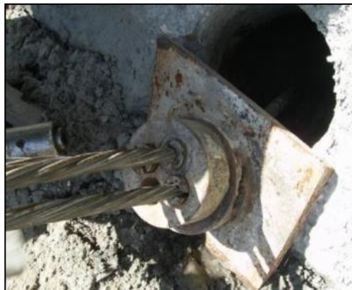
Imagen 195 Colocación de la palca y cabeza del anclaje Fuente: (Marin, 2015)
