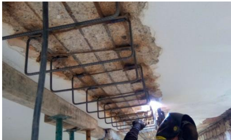
Imagen 186. Escarificación y añadidura de acero. Fuente: (Broto, 2006)
