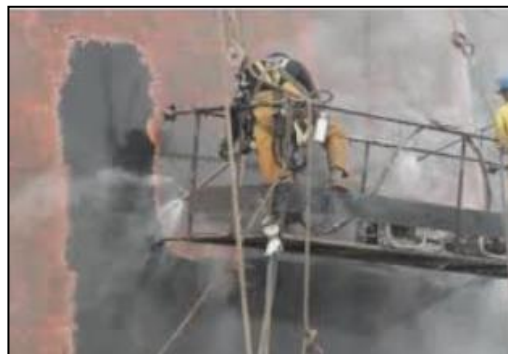
Imagen 149 Lavado de superficie a chorro Fuente: (Helene & Pereira, 2003)
