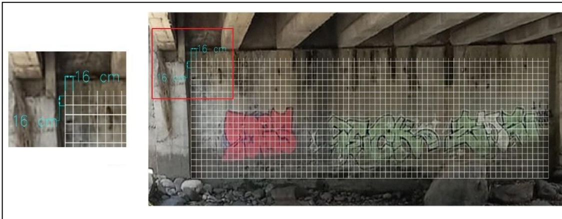
Imagen 127. Distribución de la malla, estribo izquierdo.
