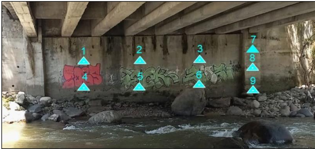
Imagen 53 Ubicación de pruebas de carbonatación en estribo
