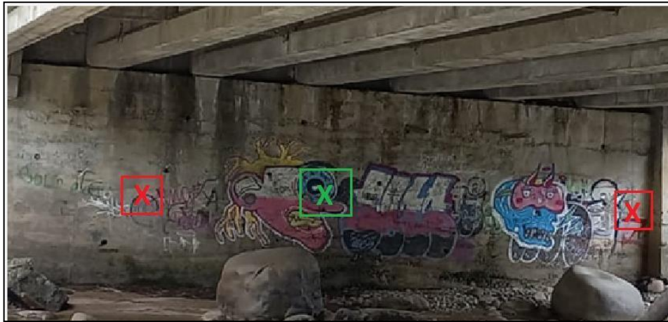
Imagen 109. Ubicación de las perforaciones, Estribo derecho.
