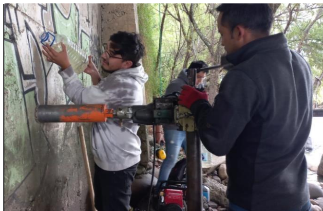
Imagen 45. Suministro de agua en la broca.
