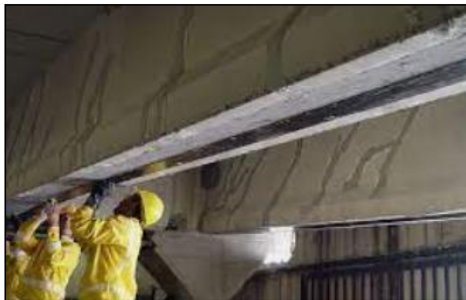
Imagen 182 Colocación de las láminas de FRP Fuente: (Machado, 2002)
