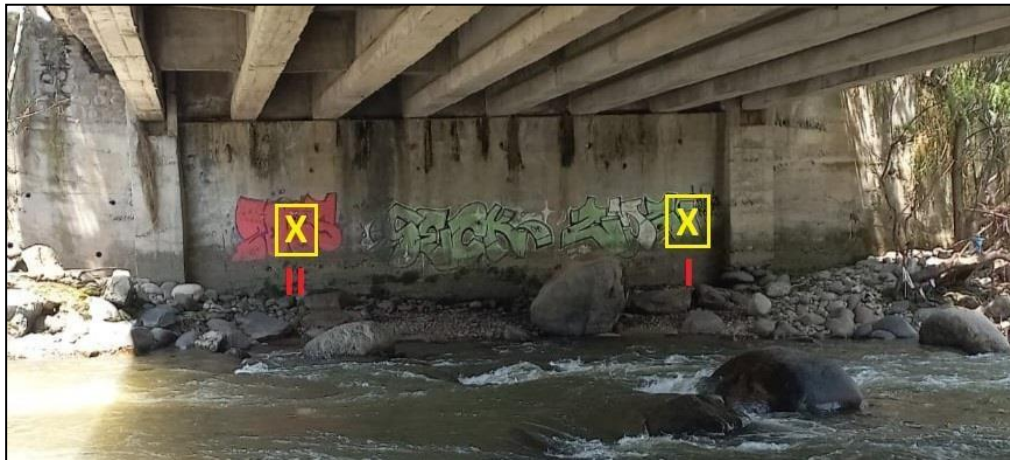
Imagen 41. Ubicación de Perforaciones para obtención de núcleos, Estribo Izquierdo.
