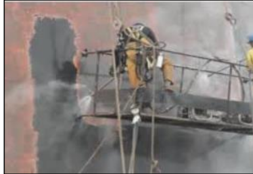
Imagen 199 Lavado de superficie a chorro Fuente: (Helene & Pereira, 2003)
