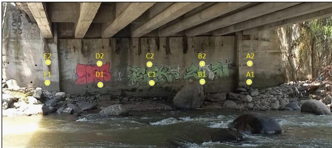
Imagen 65. Ubicación de los puntos donde se realizó el ensayo de esclerometría, en el estribo izquierdo.
