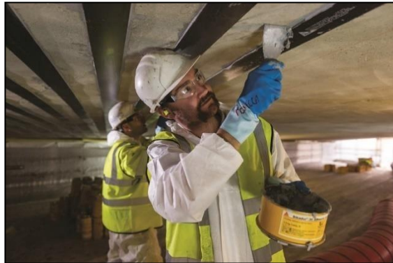
Imagen 184 Colocación de la segunda capa de imprimación Fuente: (Machado, 2002)
