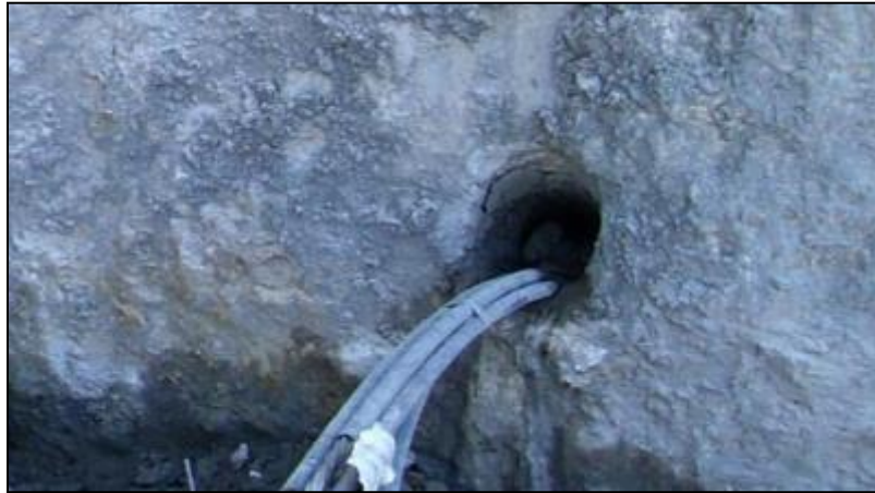
Imagen 194 Inyección de la lechada Fuente: (Marin, 2015)
