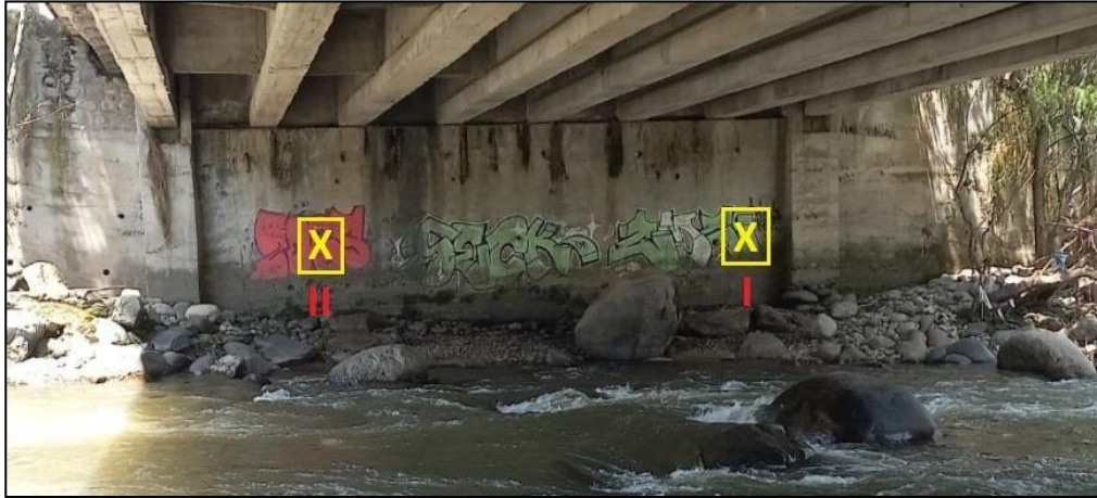
Imagen 112. Ubicación de Perforaciones, Estribo izquierdo.
