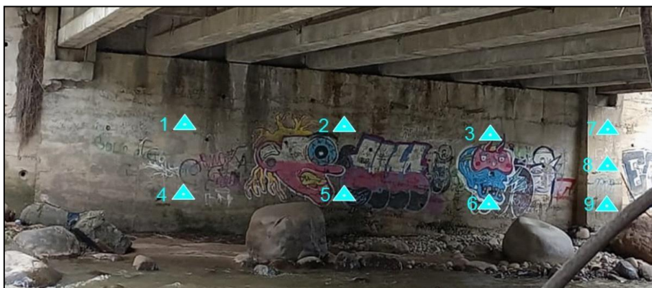
Imagen 120 Ubicación de pruebas de carbonatación en estribo.
