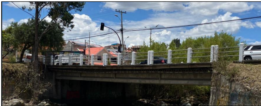
Imagen 35 Puente de vigas simplemente apoyado Fuente: (Yepes, 2017)
