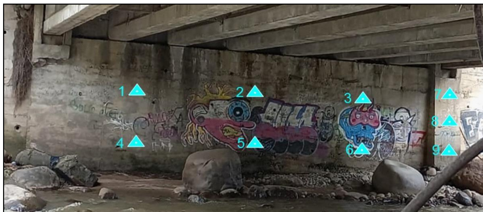
Imagen 54 Ubicación de pruebas de carbonatación en estribo.
