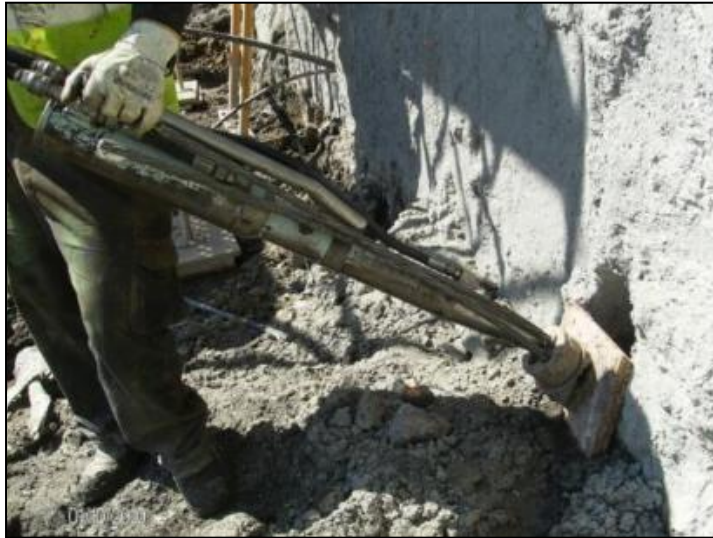
Imagen 196 Tesado de anclaje con gato hidráulico Fuente: (Marín, 2015)
