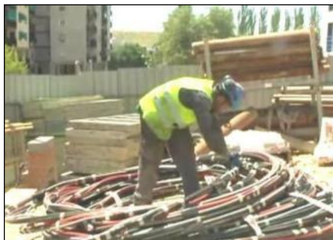
Imagen 192 Adecuación del tirante del anclaje Fuente: (Marin, 2015)
