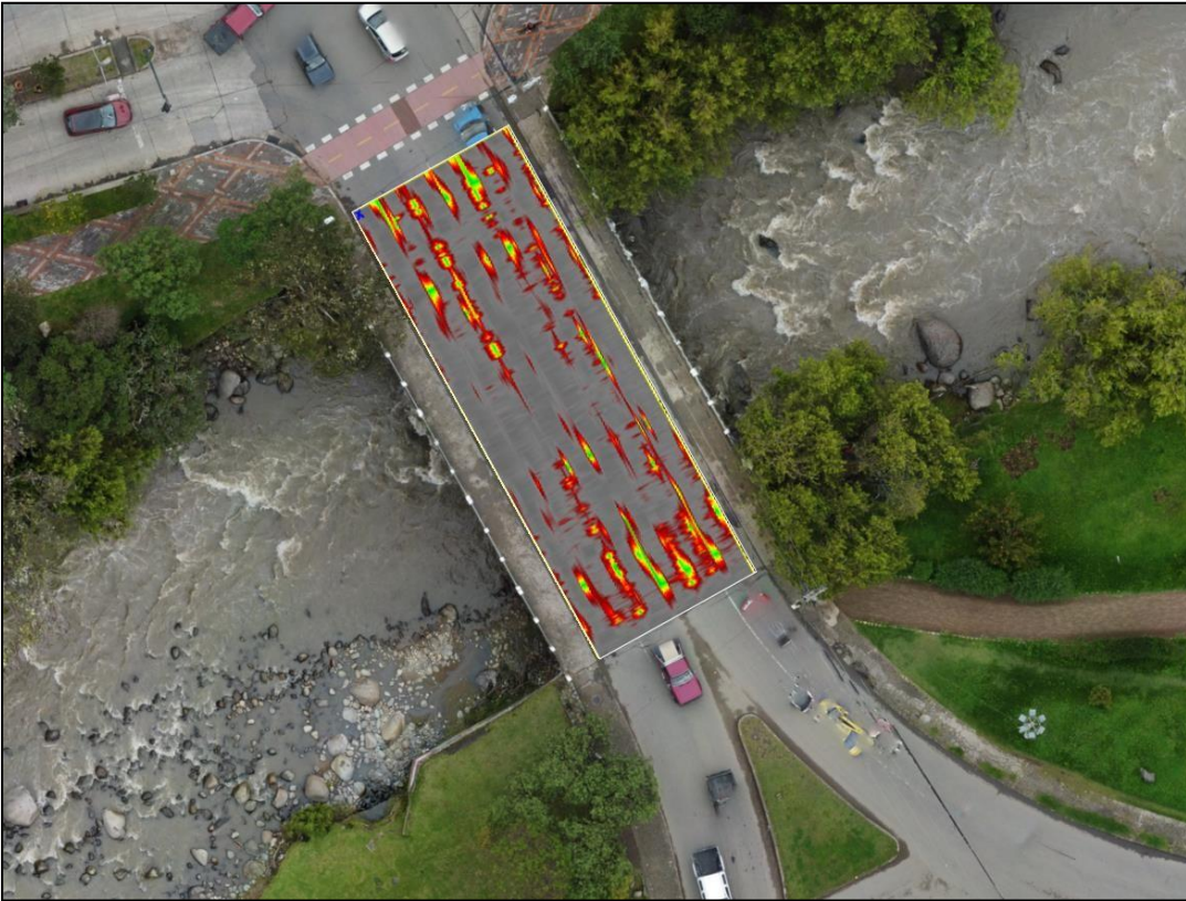
Imagen 134 Ortofoto georreferenciada en donde se puede apreciar las vigas con el georradar
