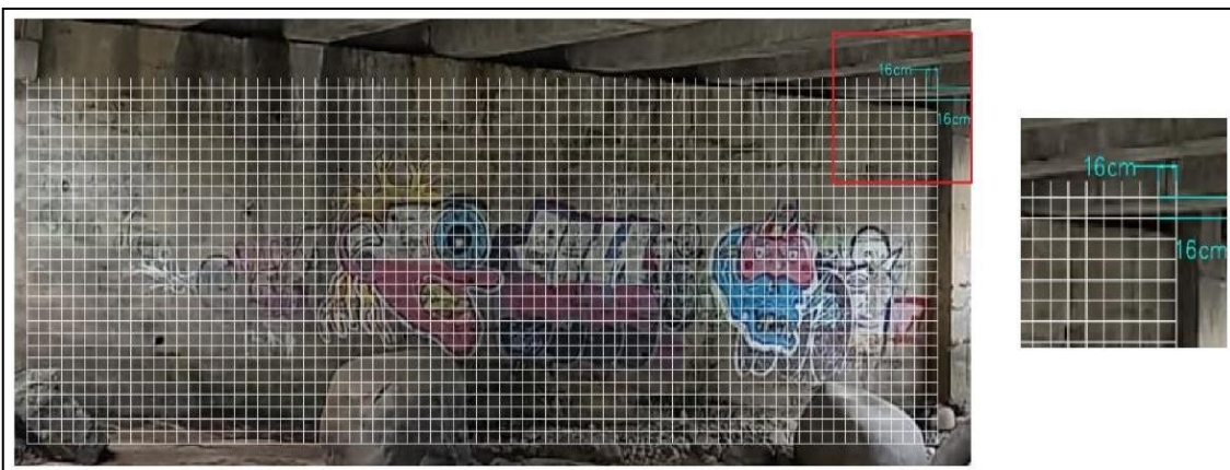
Imagen 128 Distribución de la malla, estribo derecho.
