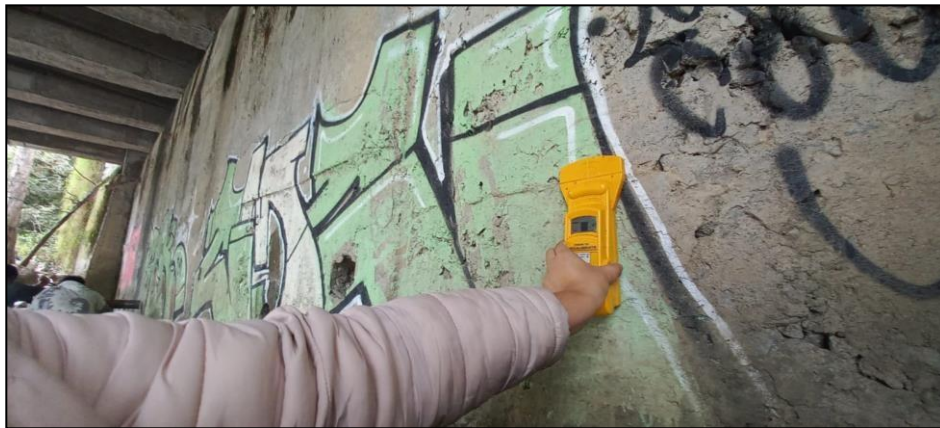
Imagen 73. Ubicación de varillas en los estribos, Estribo derecho.
