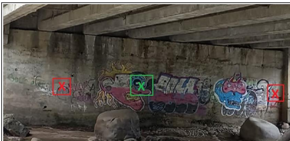
Imagen 40. Ubicación de Perforaciones para obtención de núcleos, Estribo derecho.
