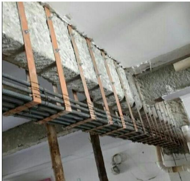
Imagen 188. Colocación de nueva armadura y encofrado. Fuente: (Navarro & Ureña, 2014)
