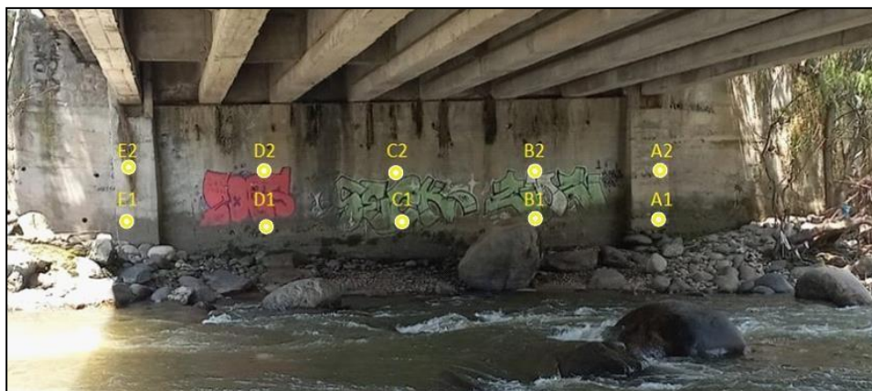
Imagen 123. Ubicación de los ensayos de esclerometría, Estribo izquierdo
