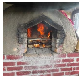
Precautado del horno
