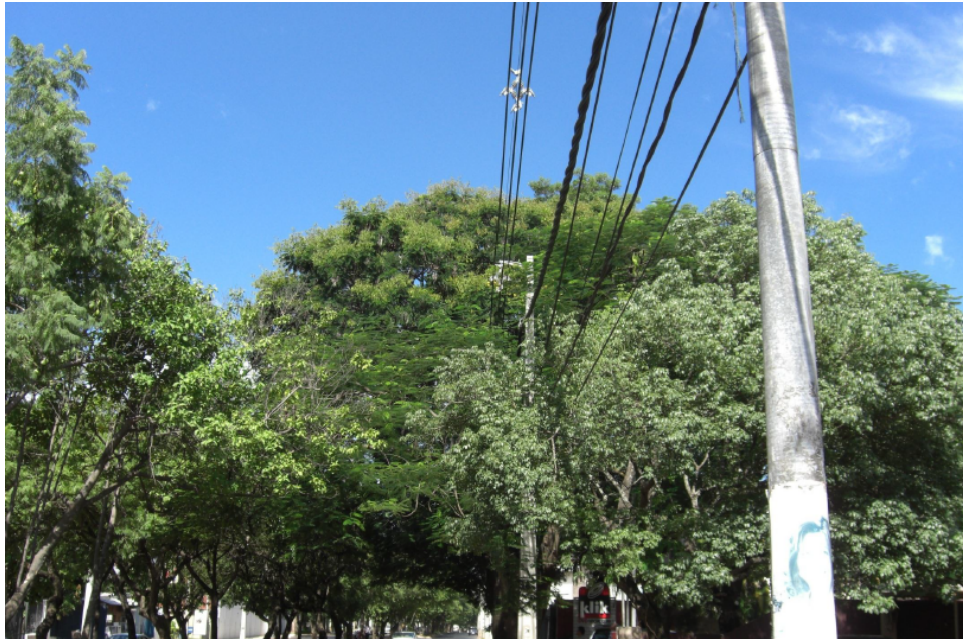
Figura 3.2: Red aérea semiaislada operando al estar en contacto con árboles [7].
