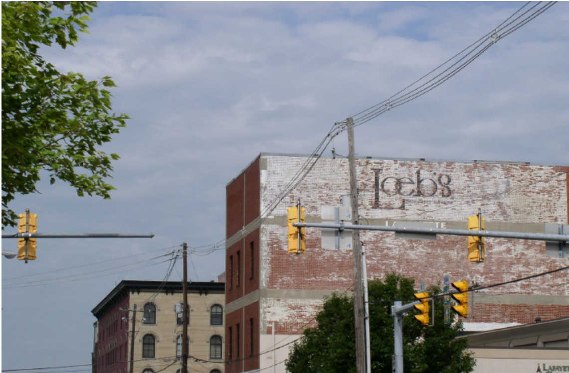
Figura 3.7: Tendido de red semiaislada en una zona urbana [2].
