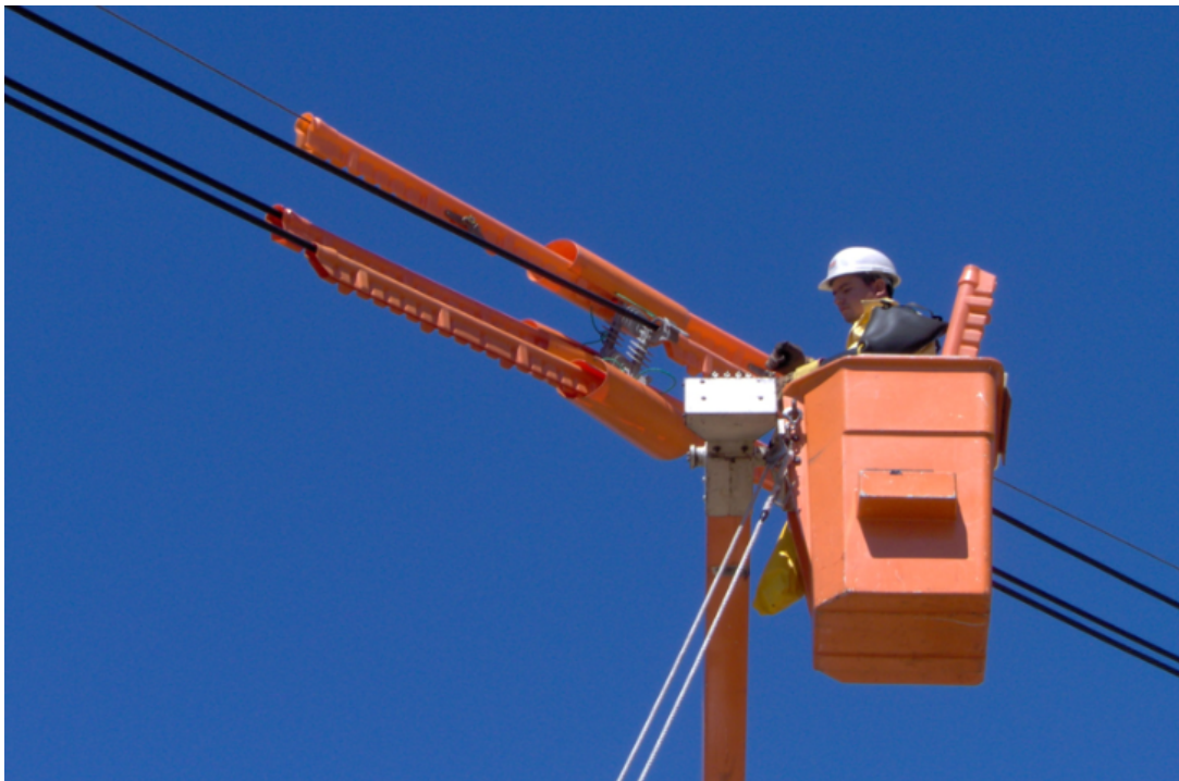
Figura 3.43: Equipos de seguridad en el trabajo con línea energizada [12]
