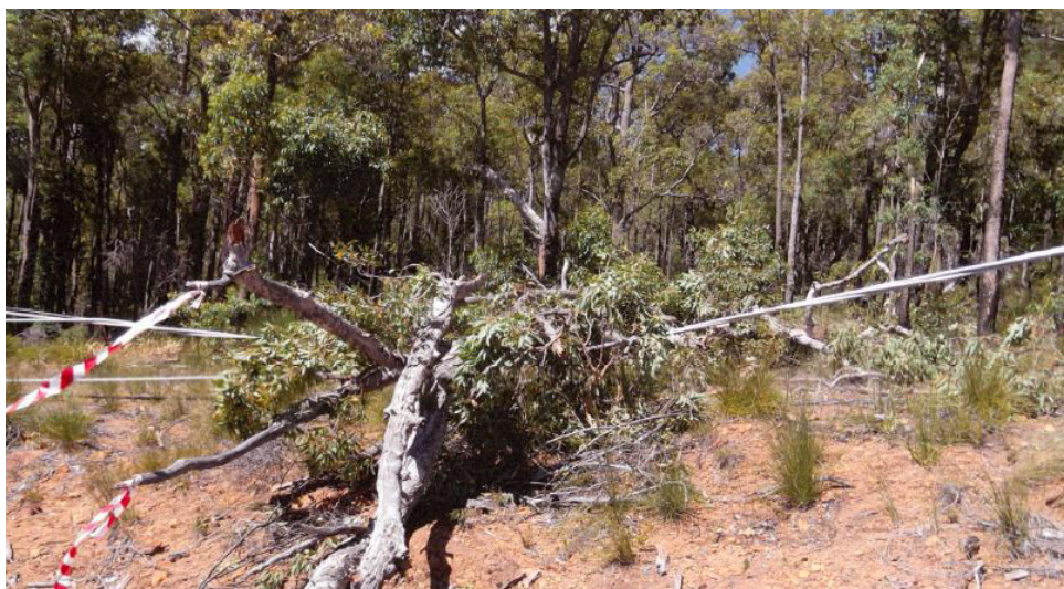
Figura 3.3: Red aérea semiaislada operando pese a la caída de un árbol en el sistema [7].
