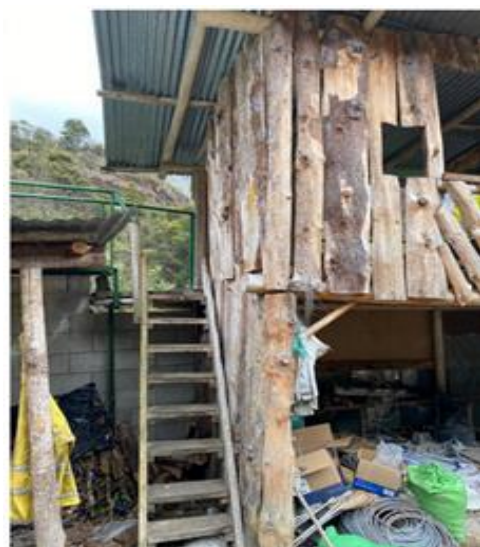
Ilustración N° 6 Título: Infraestructura Autor: Belén Barrera – Karina Ojeda Fuente: Elaboración Propia Fecha: 01 de julio, 2022
