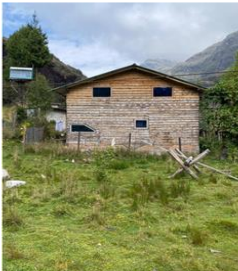
Ilustración N° 5 Título: Infraestructura Autor: Belén Barrera – Karina Ojeda Fuente: Elaboración Propia Fecha: 01 de julio, 2022
