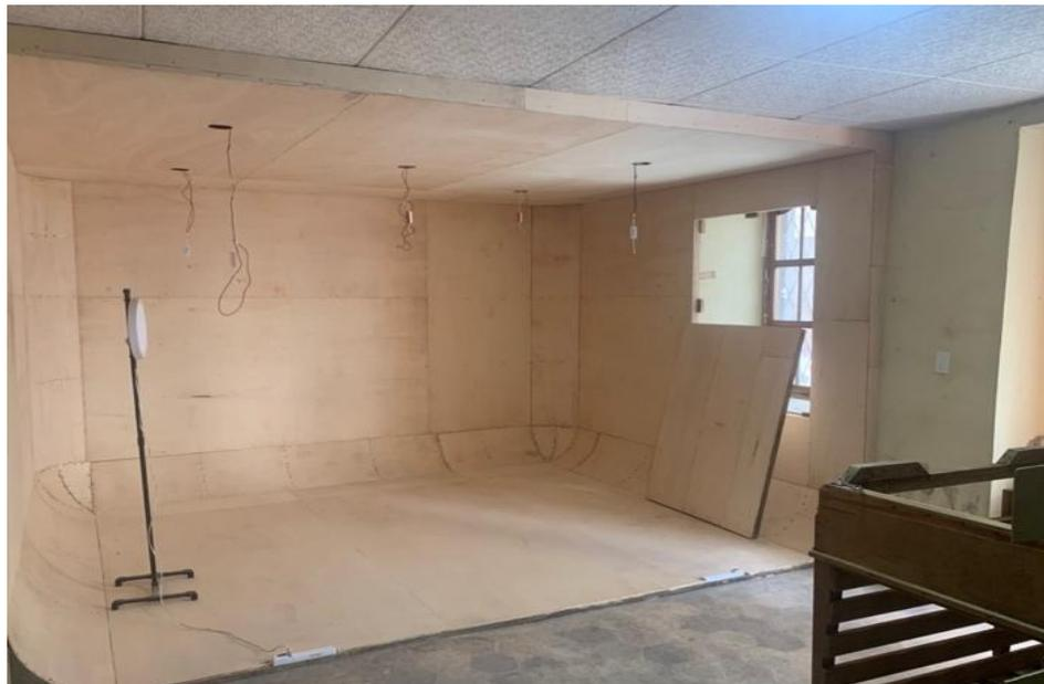
*Imagen 13 Proceso de construcción y ensamble del Cyclorama 100%.*
