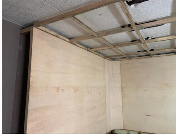
*Imagen 2 Estructura interna y cubierta del cyclorama.*
