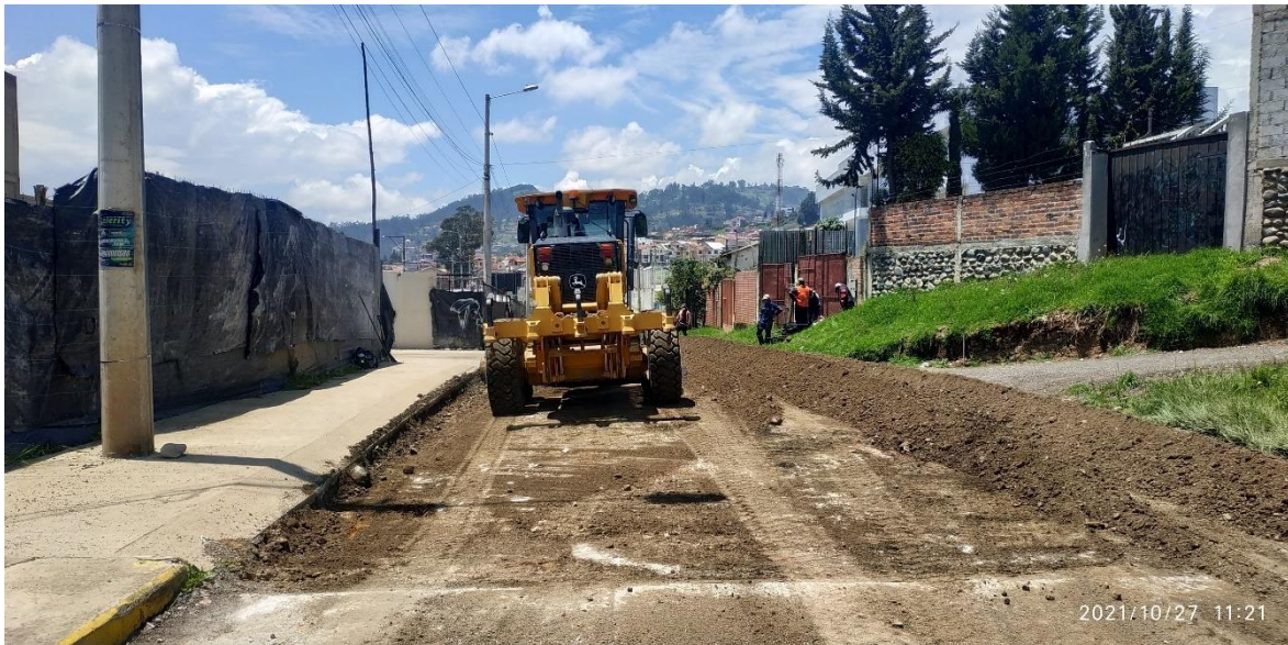
Foto 13. Tendido de material
