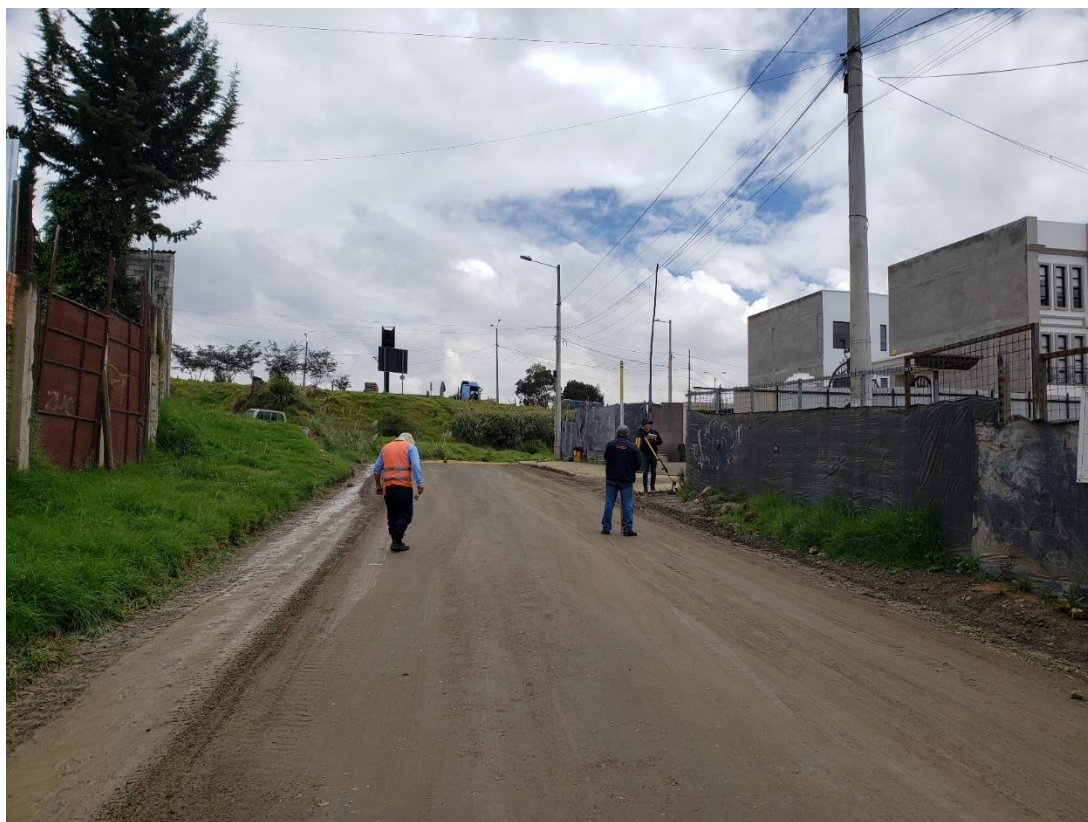
Foto 21. Nivelación de ejes
