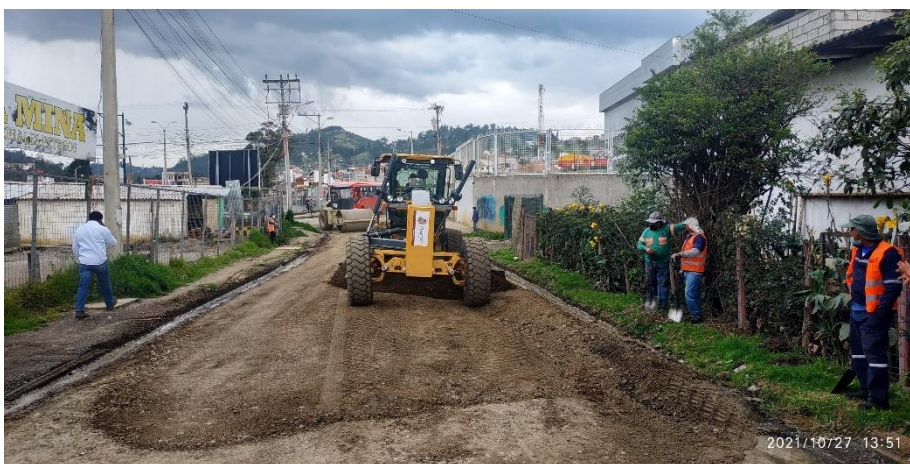
Figura 7. Conformación de la vía, calle Beethoven. Prueba Piloto.
