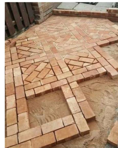
IMAGEN 43: COLOCACIÓN DE ADOQUÍN.
