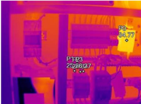
Fig. 3.15. Imagen térmica y RGB. Armario Supercondensadores.
