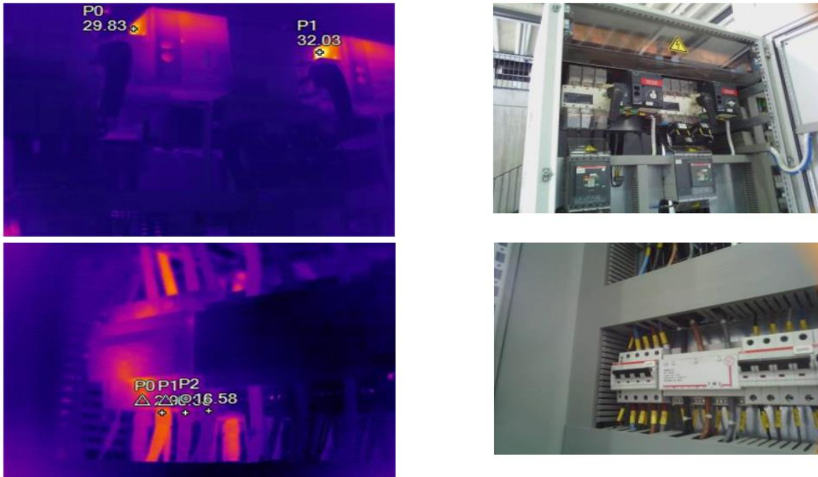
Fig. 3.22. Imágenes térmica y RGB. Panel 3B.
