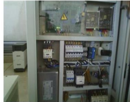
Fig. 3.15. Imagen térmica y RGB. Armario Supercondensadores.
