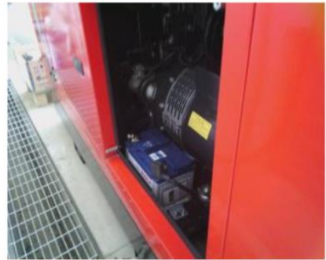
Fig. 3.11. Imagen térmica y RGB. Grupo electrógeno alimentado a Diesel.
