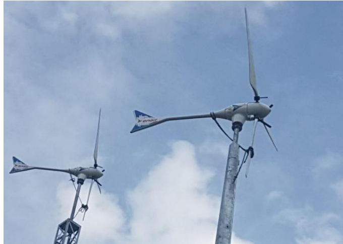
Fig. 2.17. Turbina eje horizontal ubicados en la Granja Iruis de la Universidad de Cuenca. [9]
