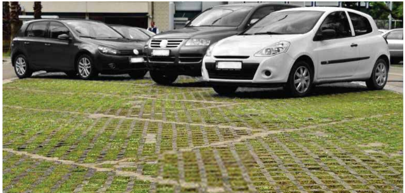
Fotografía 4.10 Materiales en estacionamientos que permiten la permeabilidad
