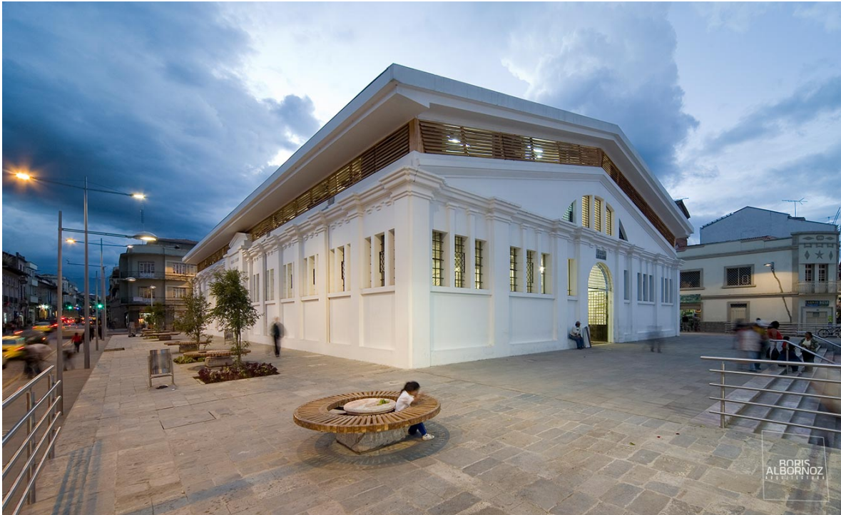
Ilustración 3: Mercado 9 de Octubre, después de la intervención
