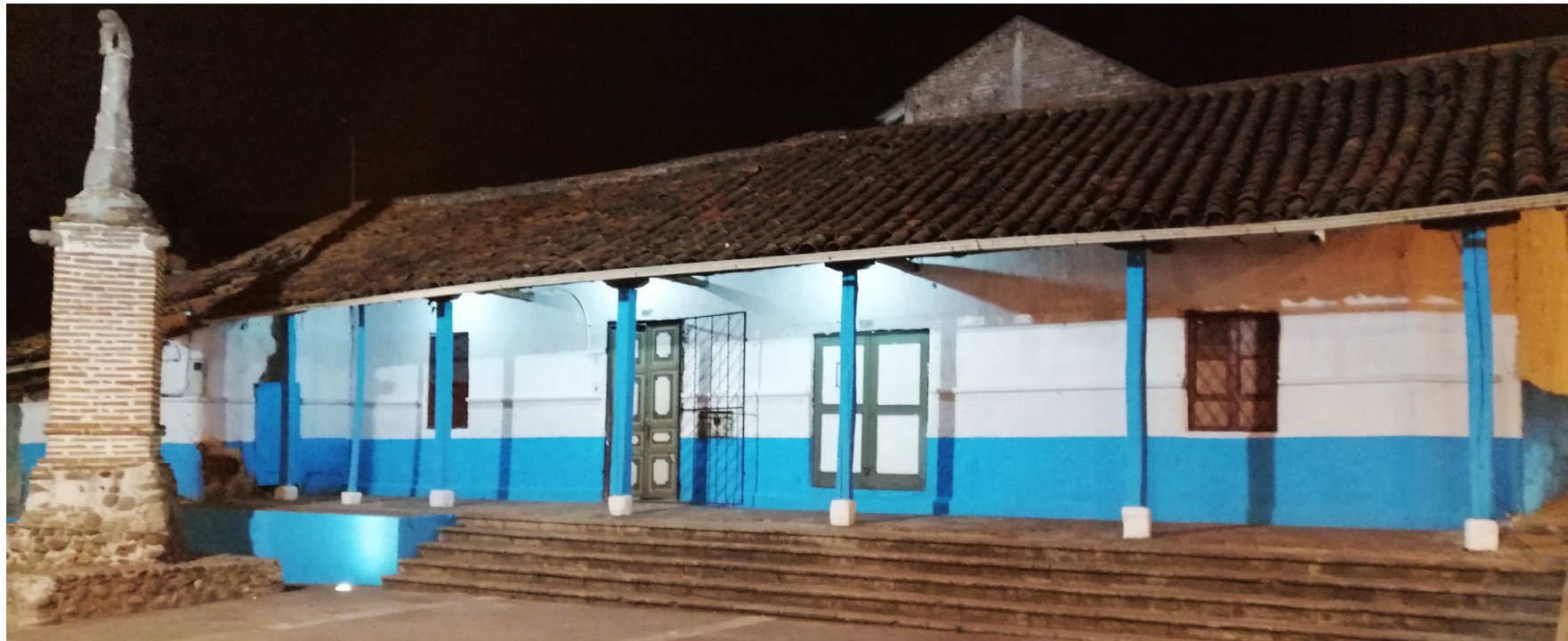
Ilustración 58. Fachada de la Vivienda el Rollo. Fuente: Johanna Llivisaca
