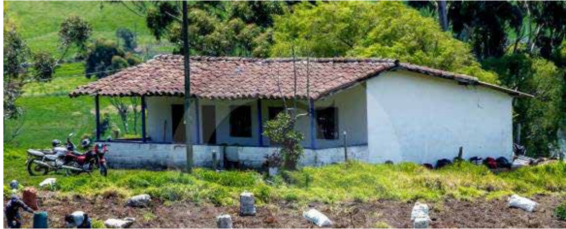
Figura 14. Vivienda rural con cubierta de dos aguas.
