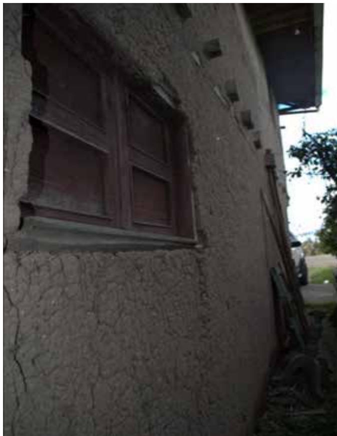
Figura 20. Muros de bahareque, vivienda rural. Fuente: Nelly Fárez (2022).
