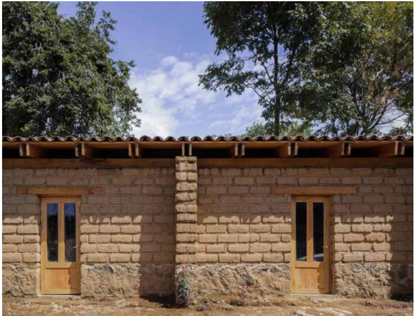
Figura 23. Fachada de vivienda de adobe Fuente: Construye Hogar (s.f.)
