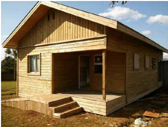
Figura 29. Vivienda de madera Fuente: Invico (s.f.)
