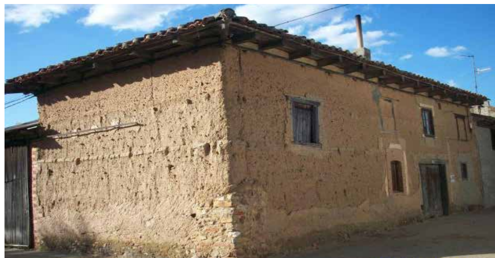
Figura 32. Vivienda con tapial Fuente: Ver Pueblos (s.f.)
