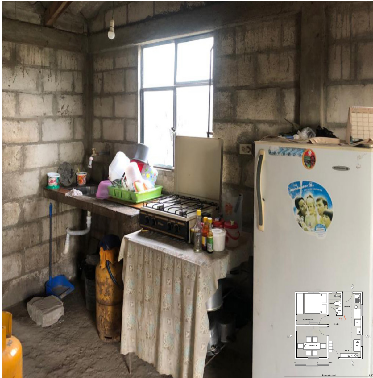
Figura 37. Levantamiento fotográfico, Zona de Cocina Fuente: Elaborado por Boris Roldán.
