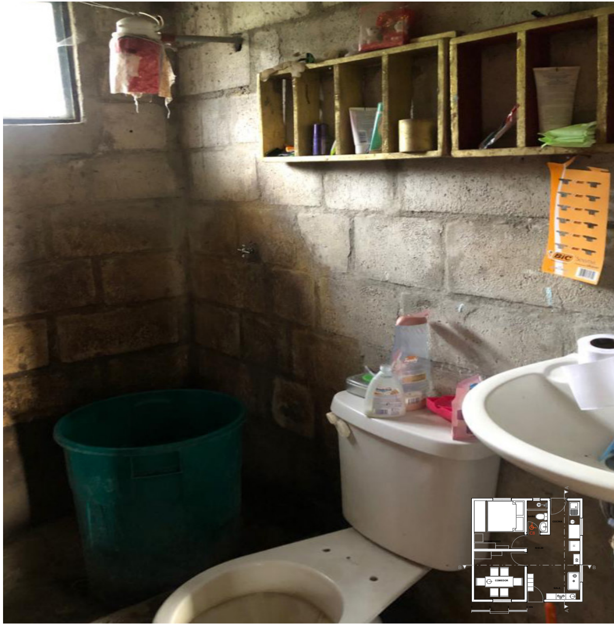
Figura 40. Levantamiento fotográfico, Zona de Baño. Fuente: Elaborado por Boris Roldán.
