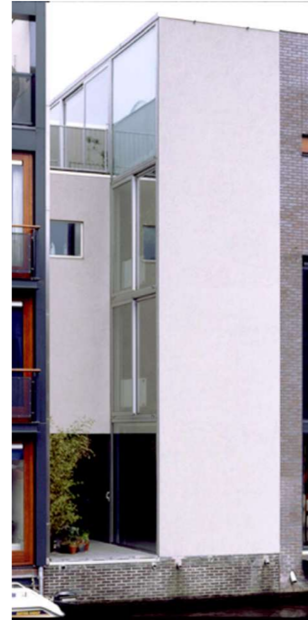
Imagen 18. Fachada posterior Casa Borneo 12, 1999 Fuente: MVRD
