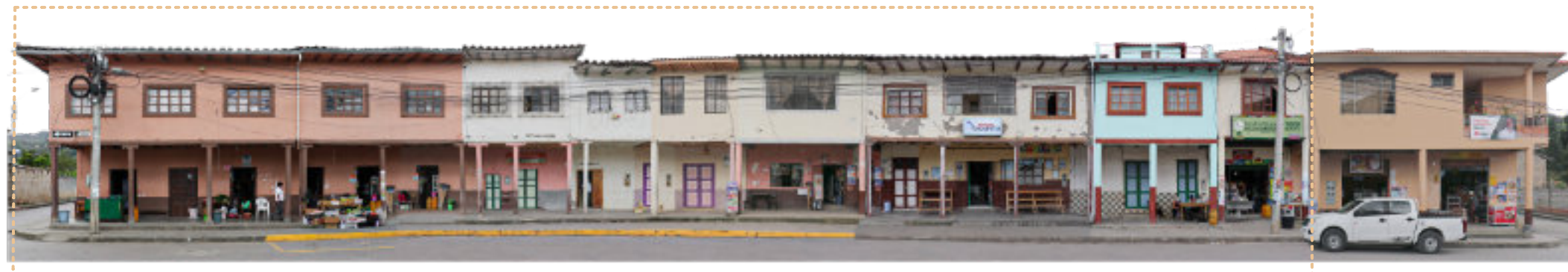
Viviendas con características patrimoniales
