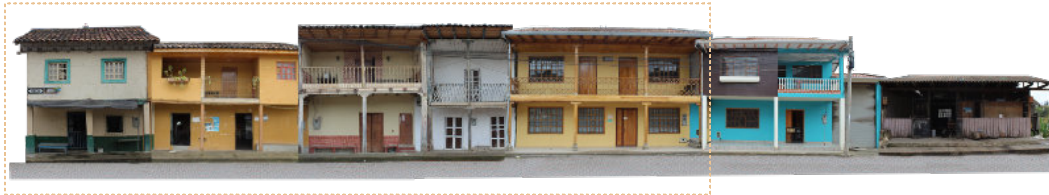
Viviendas con características patrimoniales
