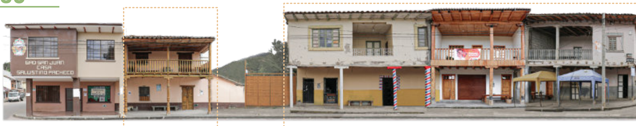
Viviendas con características patrimoniales
