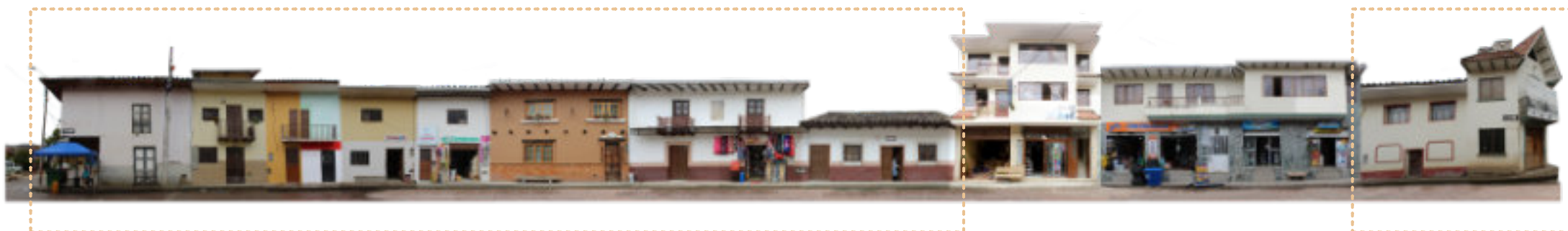
Viviendas con características patrimoniales
