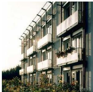
Figura N.7. Fachada Passive Haus
