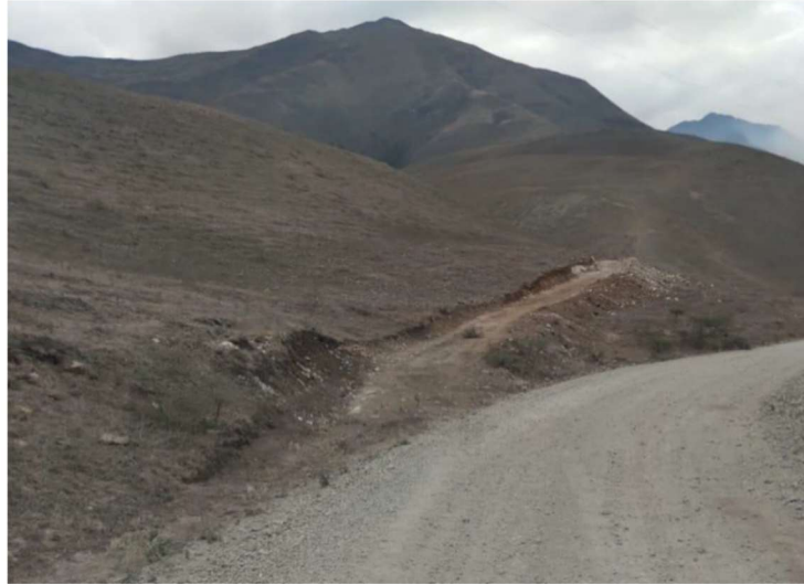
Ilustración 3. Inicio de la Vía a Yunquil (0+000.00)
