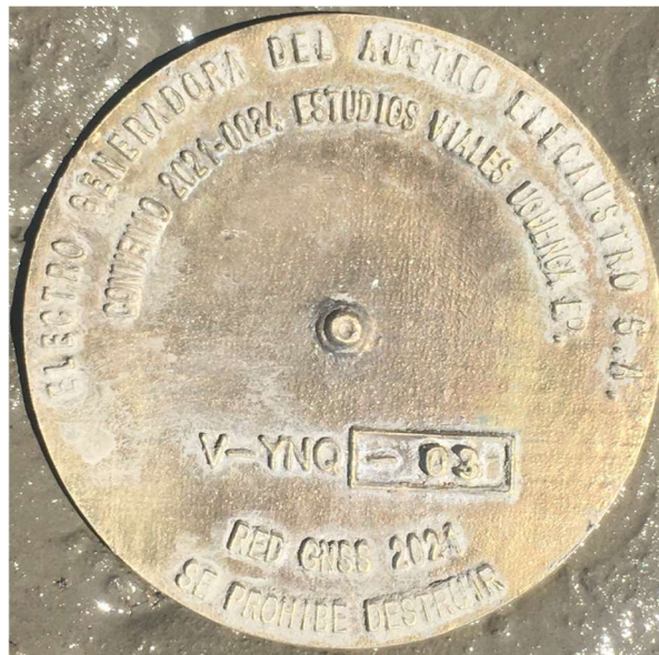
Ilustración 7. Placa informativa colocada en varios hitos o puntos de control (elementos colocados: 4)
