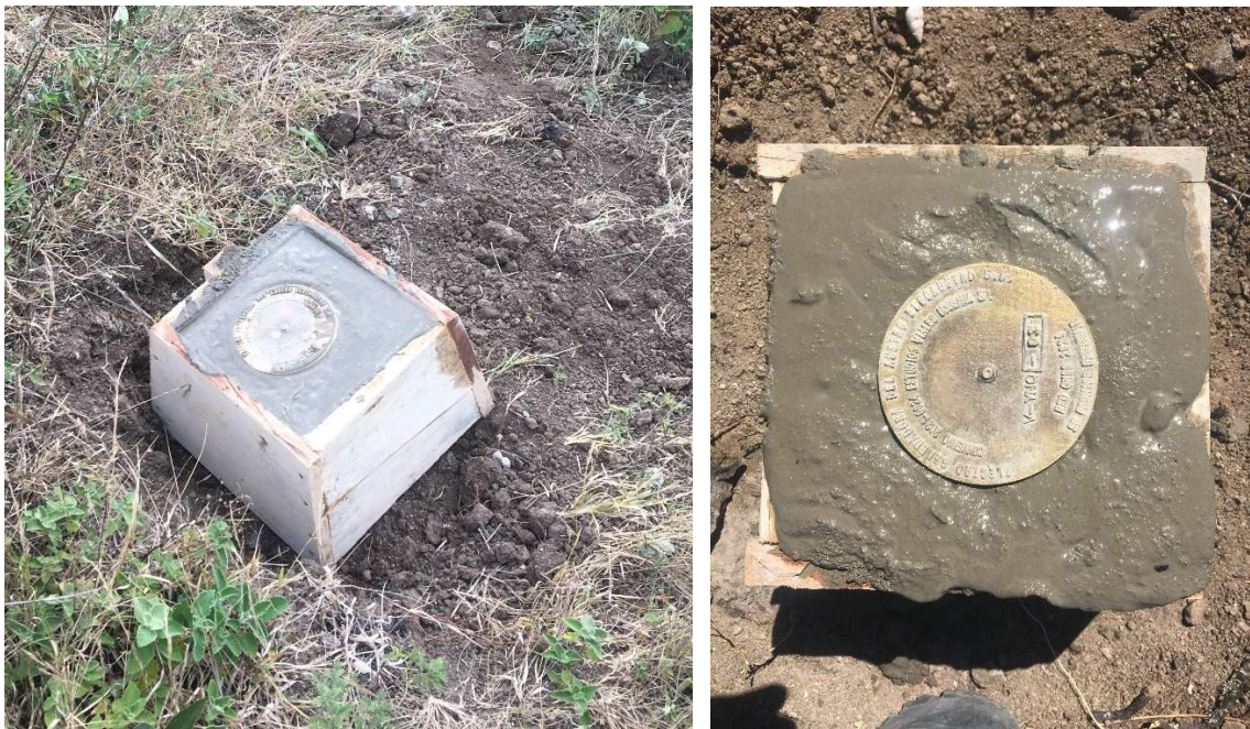
Ilustración 9. Hitos con placas informativas colocados en campo (elementos colocados: 4).
