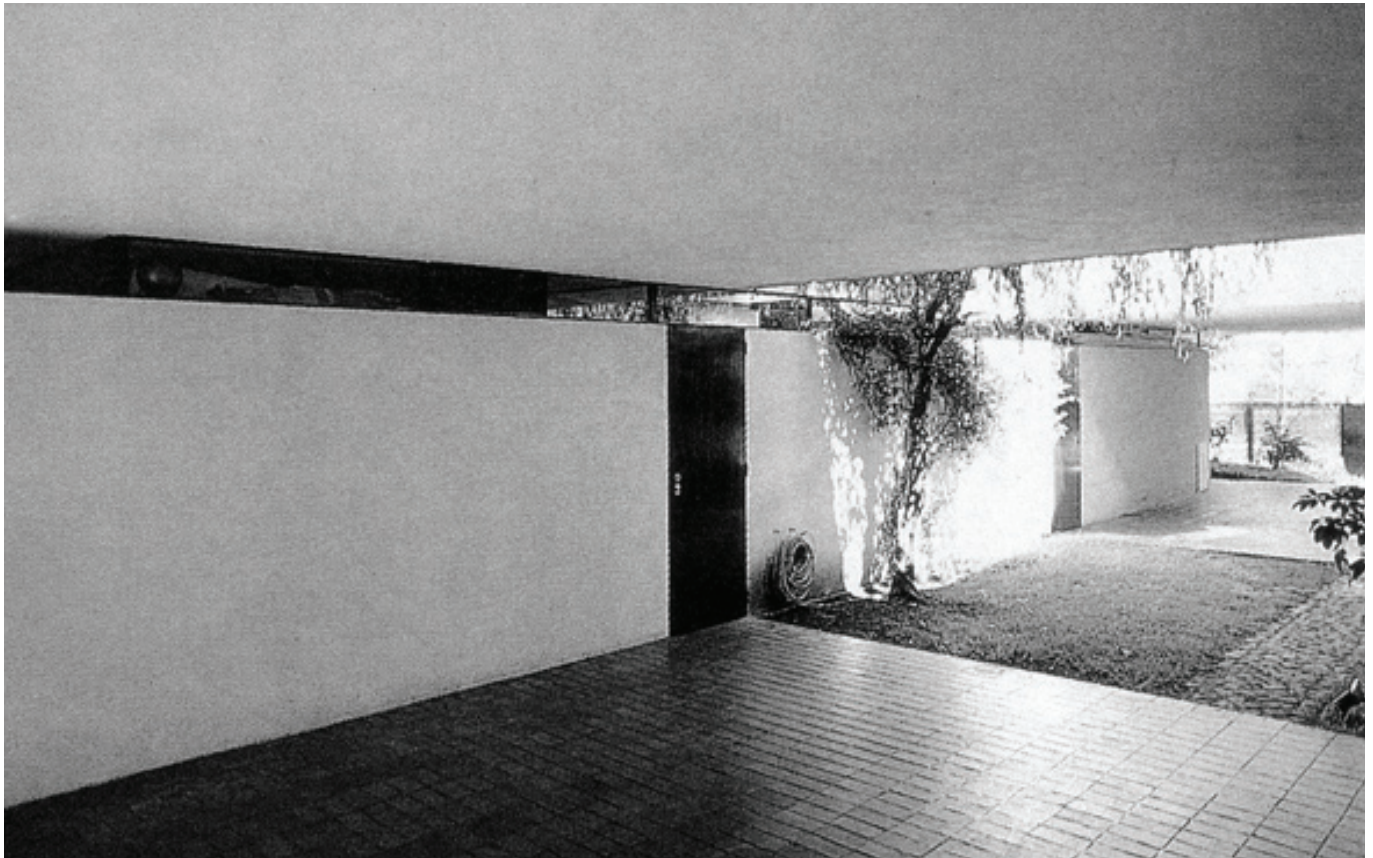
108. Casa Levin, vista de patio central en planta baja.
