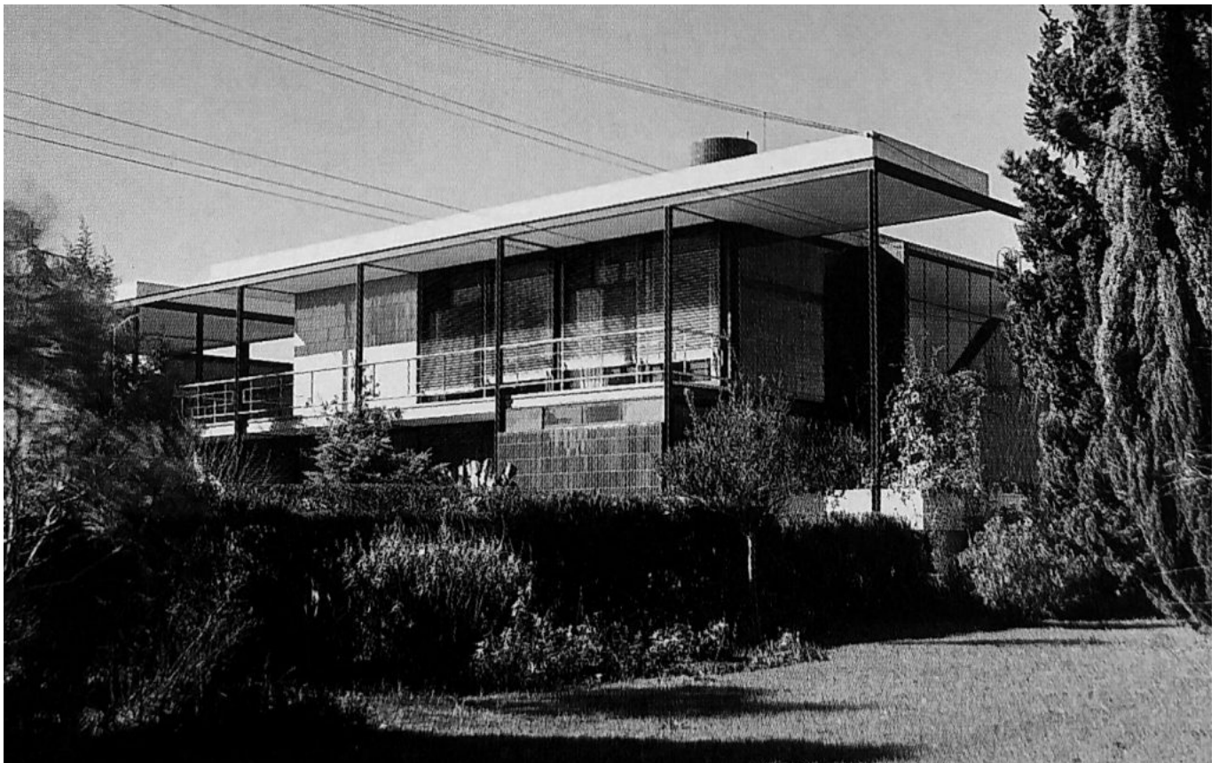
92. Casa Oks, vista exterior desde solar vecino.
