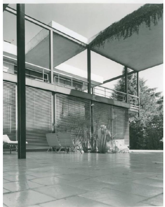
90. Casa Oks, vista exterior frontal. 91. Casa Oks, vista patio semicubierto.
