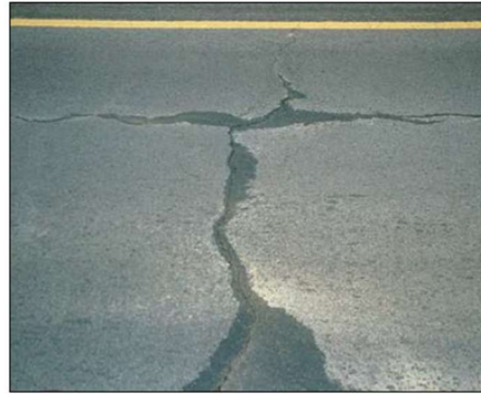
Figura 2.22: Purga y bombeo de agua [15].
