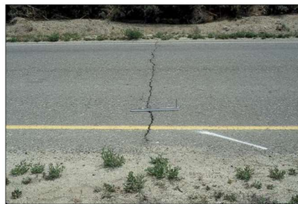
Figura 2.10: Agrietamiento Transversal [15].
