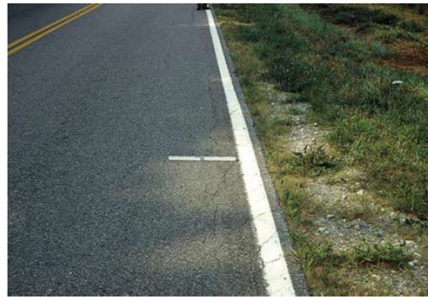
Figura 2.6: Agrietamiento de Borde [15].
