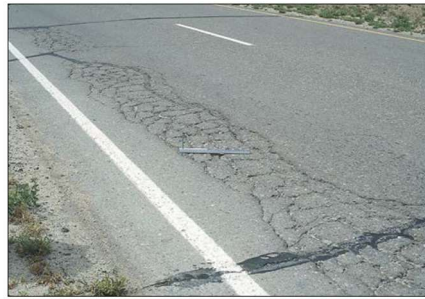
Figura 2.2: Severidad de agrietamiento por fatiga [15].
