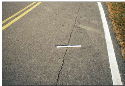
Figura 2.8: Agrietamiento Longitudinal [15].
