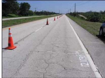
Figura 2.4: Agrietamiento en bloque [15].
