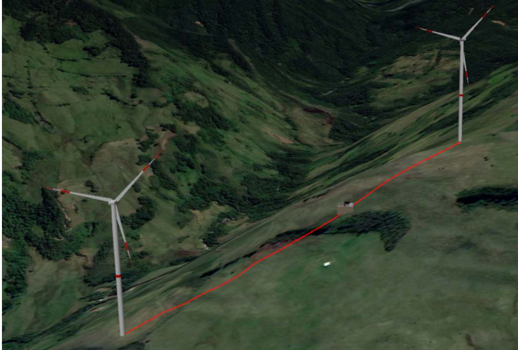
Figura 4.52: Vista en campo (Google Earth) de la conexión de la subestación con los aerogeneradores del parque eólico en Oropamba cantón Sevilla de Oro. Fuente: Propia.
