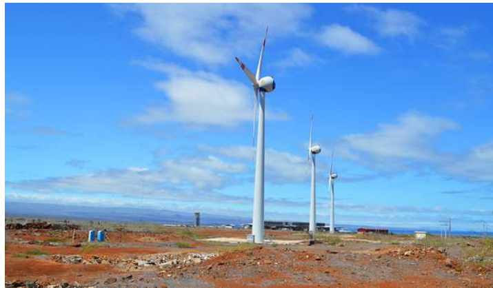
Figura 2.6: Central eólica Baltra emplazamiento ubicado en las islas Galápagos. [16]
