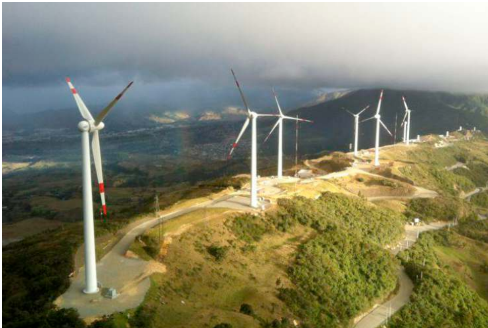
Figura 2.6: Central eólica Villonaco. [15]
