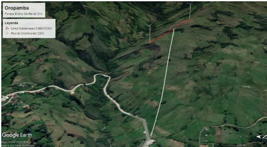
Figura 4.49: Vista en campo (Google Earth) de la infraestructura eléctrica básica parque eólico en Oropamba cantón Sevilla de Oro. Fuente: Propia.
