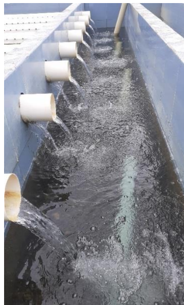
Figura 30. Proceso de prefiltración luego de la sedimentación Fuente: Autores
