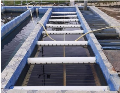
Figura 28. Sedimentador laminar de placas paralelas Fuente: Autores
