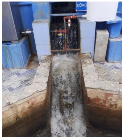
Figura 21. Vertedero rectangular para resalto hidráulico Fuente: Autores
