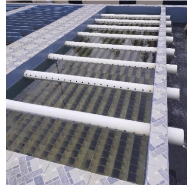
Figura 29. Sedimentador tubular Fuente: Autores
