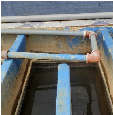
Figura 26. Flauta de dosificación del polímero catiónico Fuente: Autores
