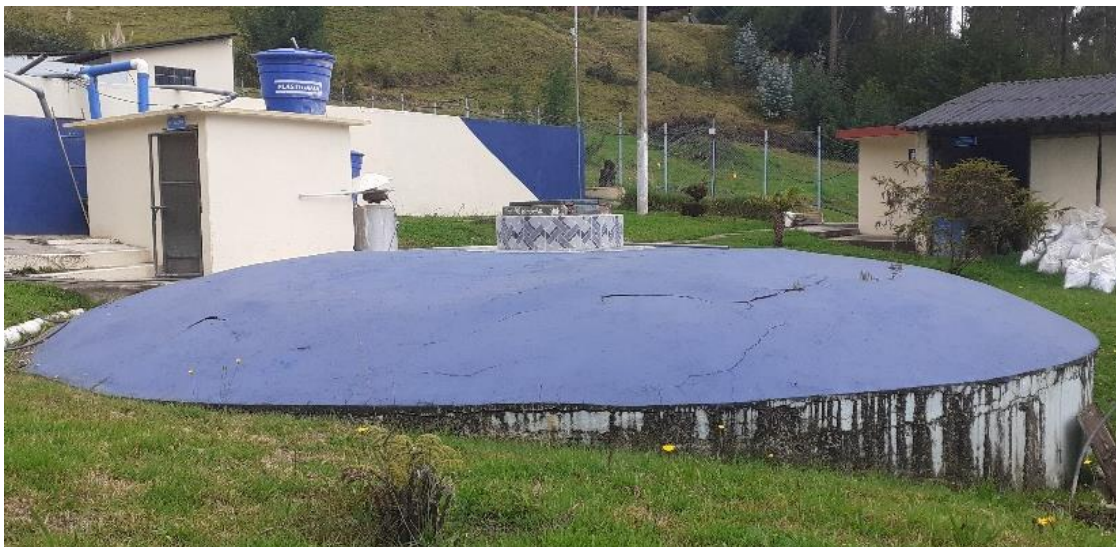
Figura 37. Tanque de almacenamiento de agua tratada Fuente: Autores
