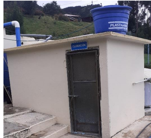
Figura 36. Cuarto de cloración Fuente: Autores
