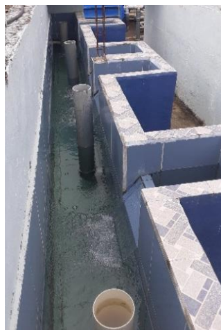
Figura 34. Canal de recolección de agua proveniente de la filtración rápida Fuente: Autores
