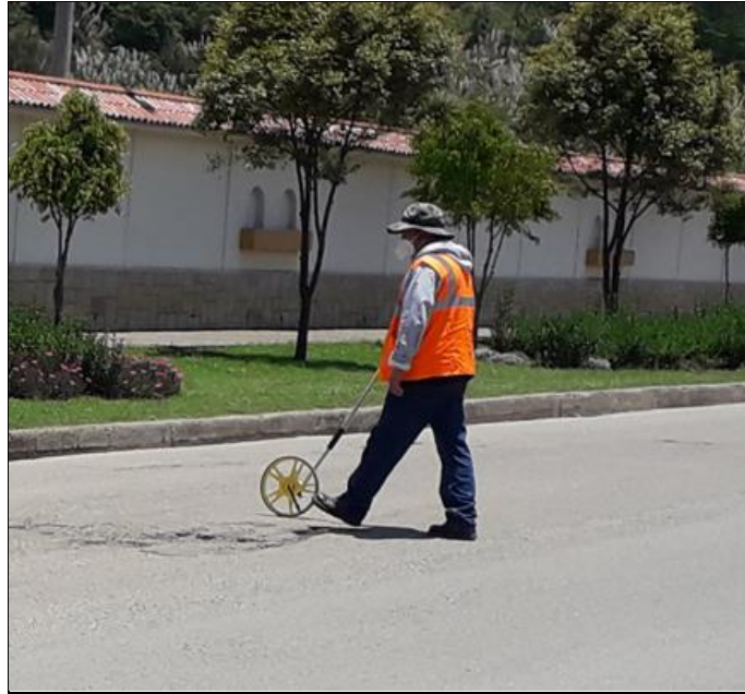
Figura 12. Utilización de odómetro manual
