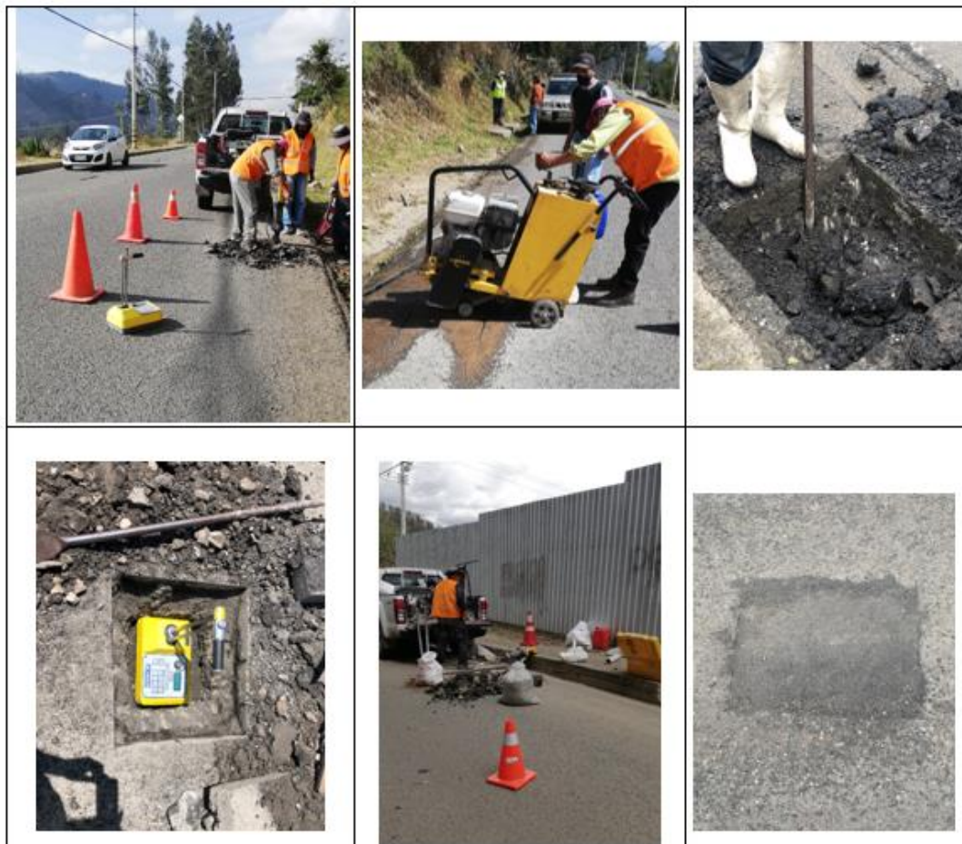
Figura 19. Ejecución de Calicatas en abscisas determinadas
