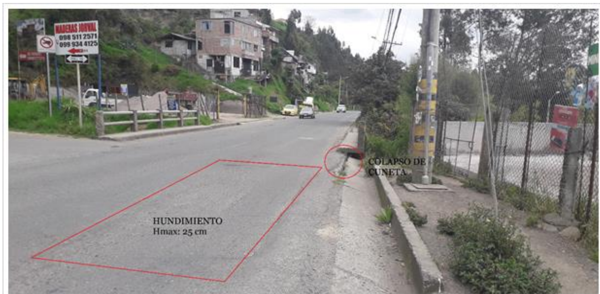
Figura 43. Hundimiento abscisa 1+040
