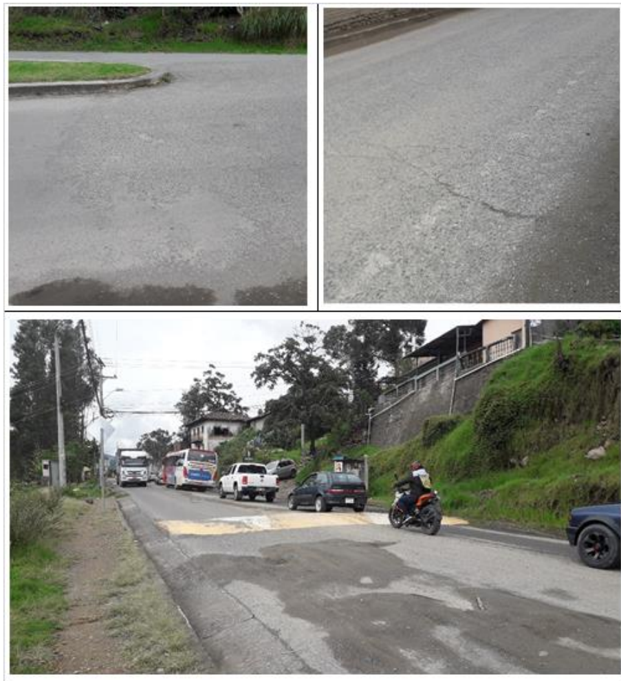
Figura 44. Meteorización de intensidad media (0+000 y 9+200). Derrame de materiales pétreos (0+600)
