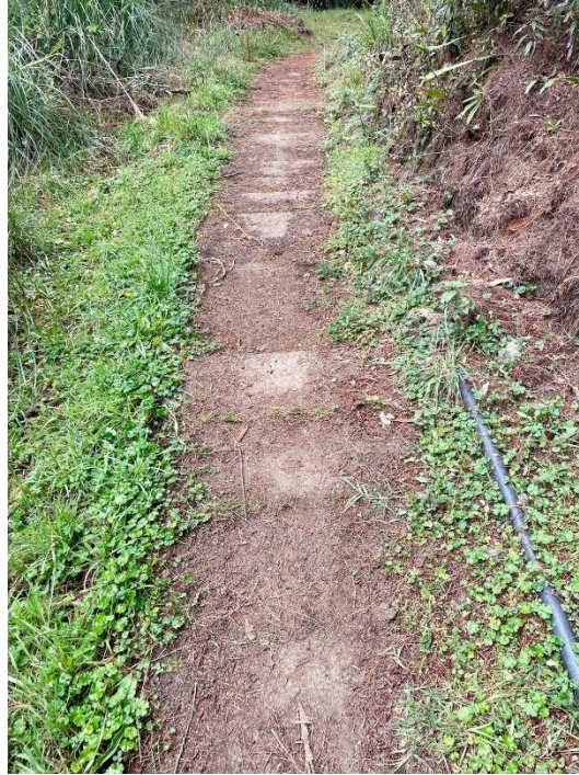
Anexo 8 Tramo de la línea de conducción cubierta del agua cruda proveniente de las quebradas Nudpud y Llaucay, microcuenca del río Tabacay
