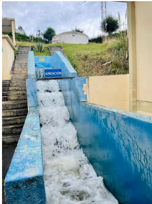
Anexo 14 Inicio del proceso de potabilización del agua cruda en la PTAP-M
