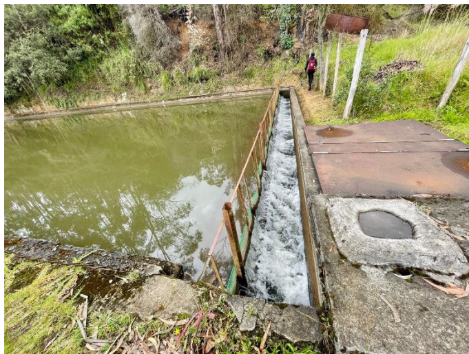
Anexo 12 Sección final del reservorio de agua cruda en la PTAP-M. Ingreso del agua cruda del reservorio a la tubería (1 km) para ingresar a la PTAP-M
