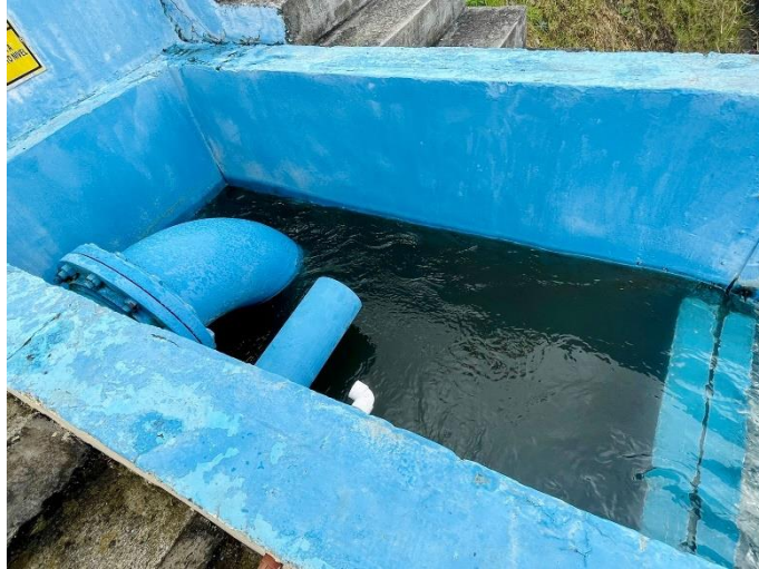
Anexo 13 Ingreso del agua cruda de la tubería (1 km) a la PTAP-M. Punto de medición del nivel de turbidez del agua cruda
