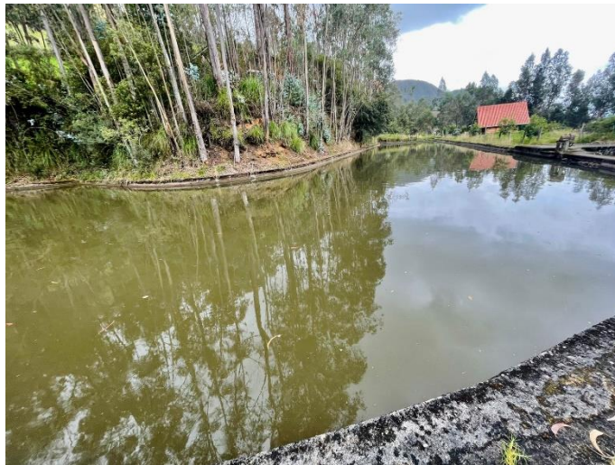
Anexo 11 Continuación del reservorio de agua cruda en la PTAP-M
