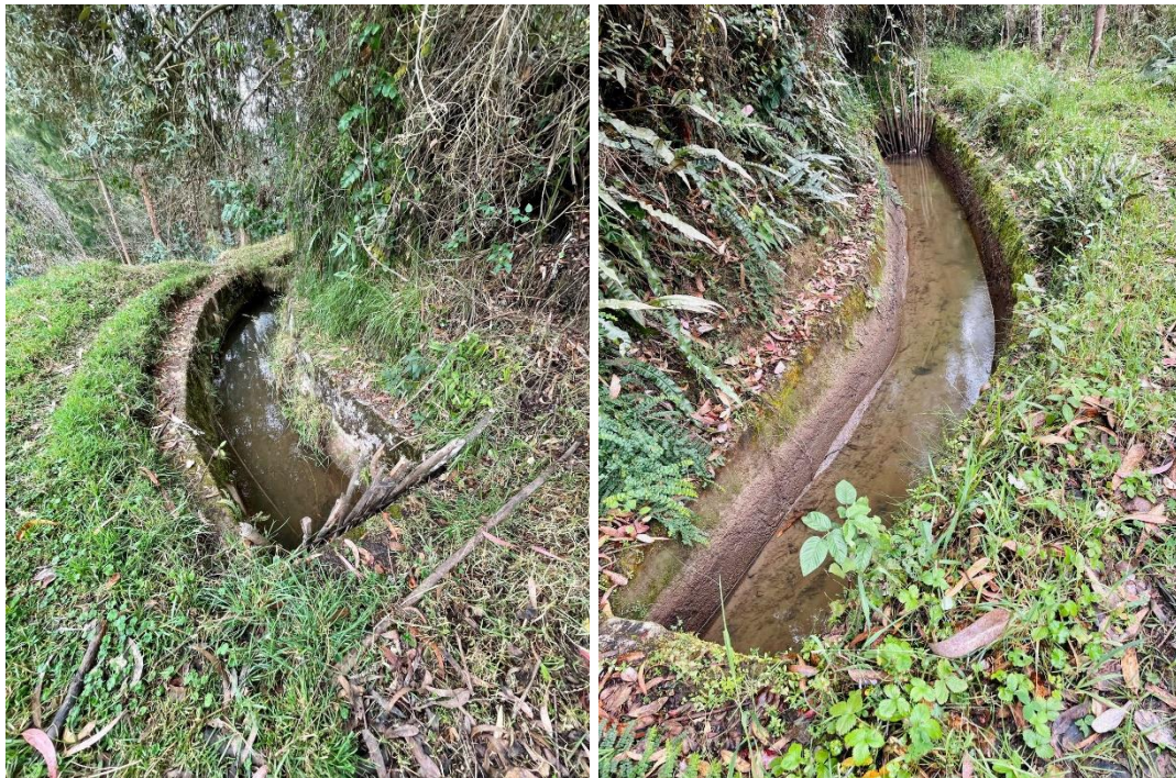
Anexo 7 Tramos de la línea de conducción a cielo abierto del agua cruda proveniente de la quebrada Nudpud, microcuenca del río Tabacay
