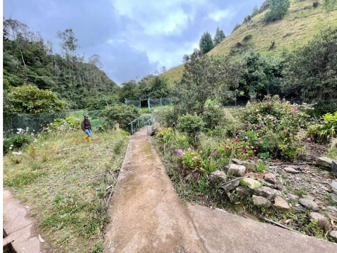
Anexo 6 Zona aledaña al sistema de captación de agua cruda de la quebrada Llaucay, microcuenca del río Tabacay
