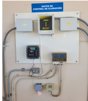
Ilustración 333. Control de peso de cilindros de cloro.
