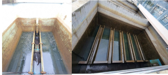
Ilustración 7. Caja de filtro modulo I (Izquierda), modulo II (Derecha). En un proceso de lavado. Fuente: Abad – Guaraca
