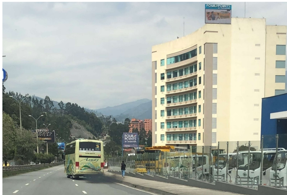
Parada 3. Mall del Río, Autopista Cuenca – Azogues.
