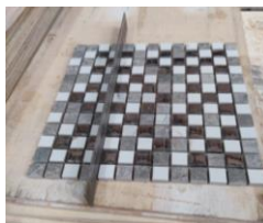
Ilustración 37: Control de paralelismo con regla
