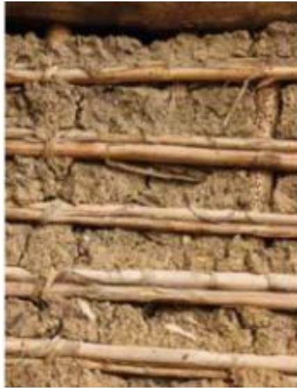
Ilustración 3 Técnica constructiva de Bahareque
