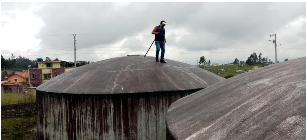
Ilustración 33. Levantamiento de los tanques de almacenamiento
