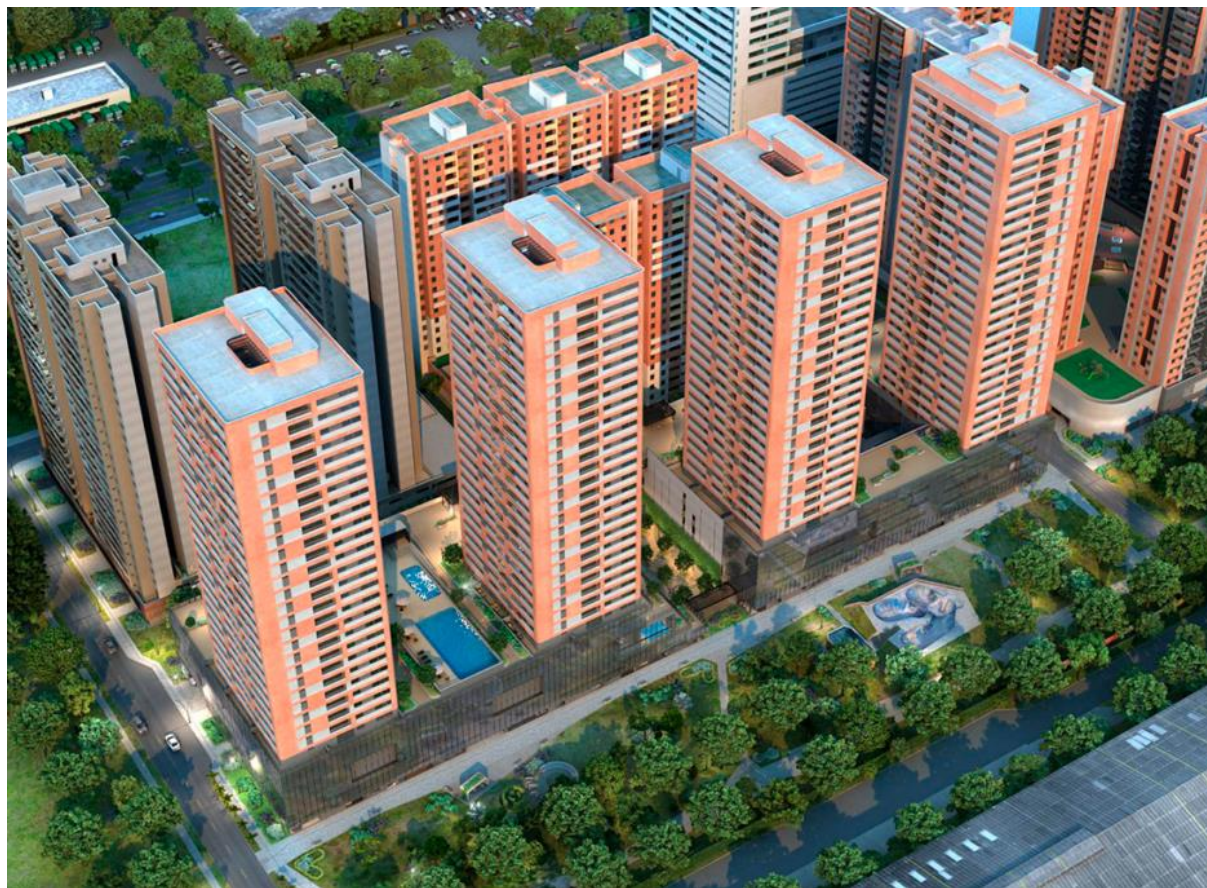
Figura 4.44 Edificios residenciales en Ciudad del Río, Medellín, 2020.
