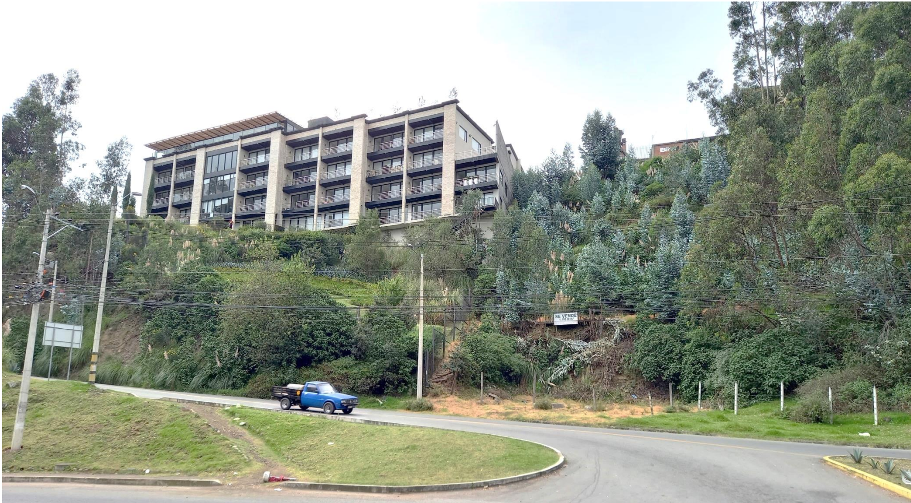
Figura 4.27 Edificaciones emplazadas en zonas con limitaciones para la urbanización por susceptibilidad a deslizamientos en masa, Cuenca – Ecuador, 2022.
