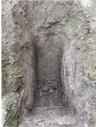
Ilustración 24 Calicata C#13 Fuente: Juan Vanegas
