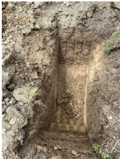
Ilustración 23 Calicata C#12 Fuente: Juan Vanegas
