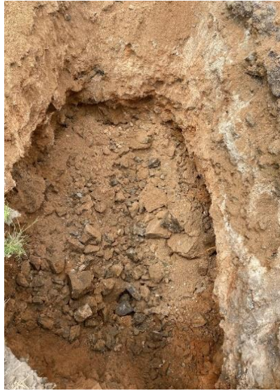
Ilustración 18 Calicata C#7 Fuente: Juan Vanegas
