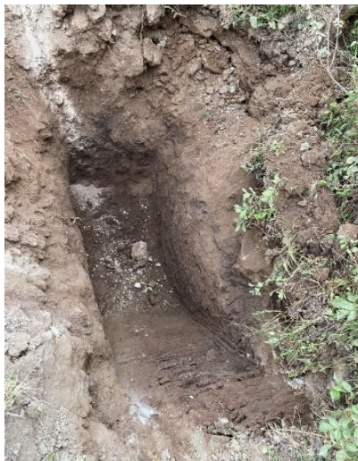
Ilustración 20 Calicata C#9 Fuente: Juan Vanegas
