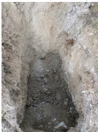
Ilustración 16 Calicata C#5 Fuente: Juan Vanegas
