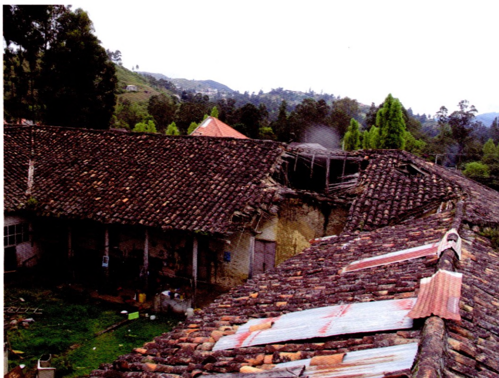
Obras emergentes en el Hospital Viejo de Gualaceo, tapiales, Ecuador (créditos: Lourdes Abad)
