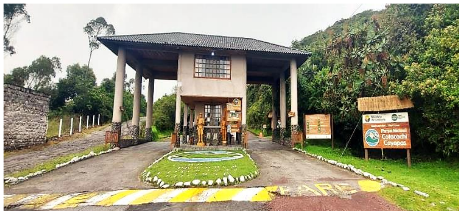
Garita de control al ingreso del PNCC en la zona baja.
