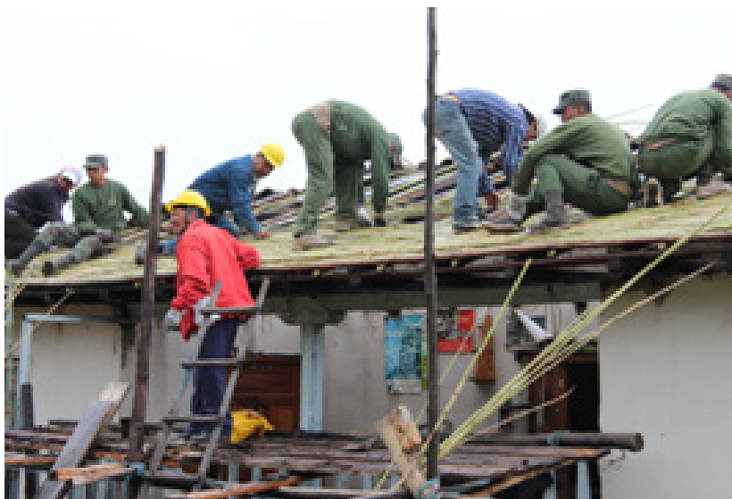
Fig. 6: Una de las cubiertas intervenidas íntegramente Plan Piloto de Conservación Preventiva aplicado a las viviendas de Susudel, 2011.
