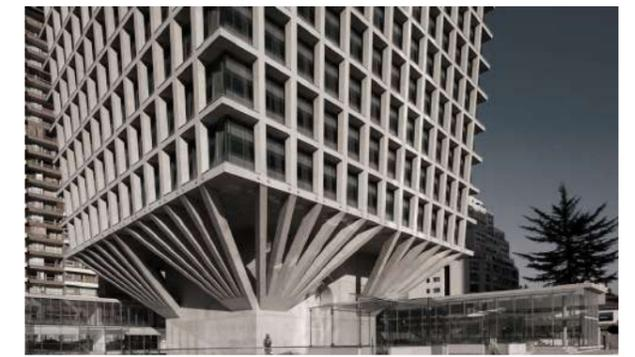
Fuente: Estructura mixta de hormigón y acero. (Palma,2012).
