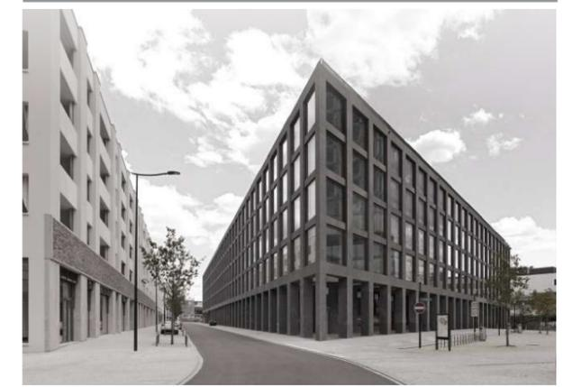
Nita: Edificio con porticos resistentes a momento de hormigón (Müller,2014).
