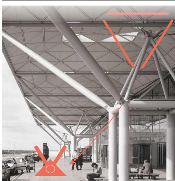
Fuente: Estructura con barras en la cubierta y apoyos que conectan las columnas y las vigas (Navarro,2019). Adaptación realizada por Cárdenas & Ruilova (2021).
