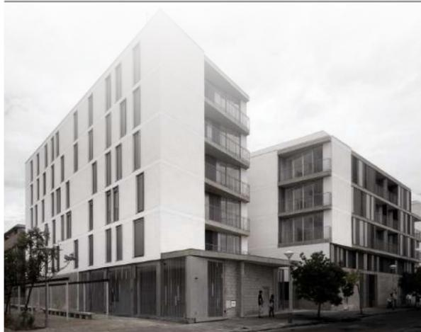
Fuente: Edificio con muros de corte de hormigón (Halbe, 2013).
