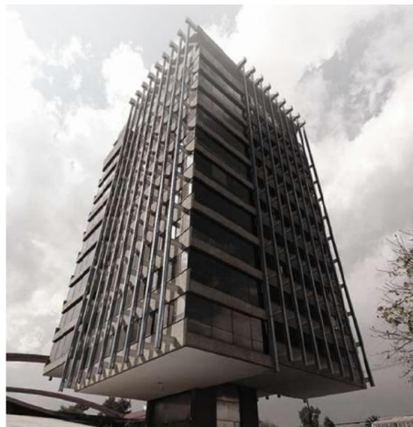
Fuente: Pórticos de acero con muros de corte de hormigón colocado in situ (Acerobsv,2020).
