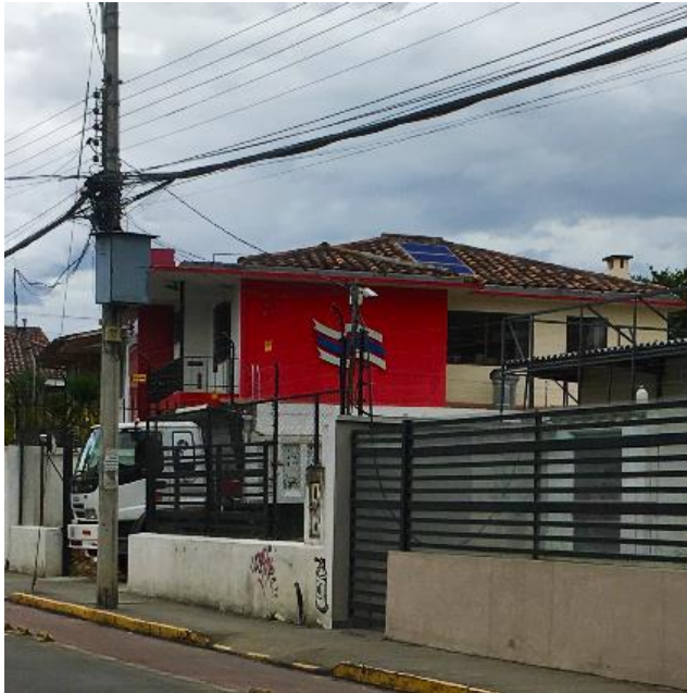
Figura 4-89 Vista de paneles PV, desde la calle, predio 011, tramo F
