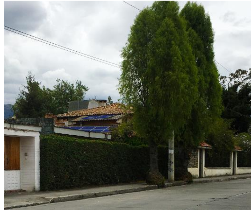
Figura 4-86 Vista de paneles PV, desde la calle, predio 004, tramo E
