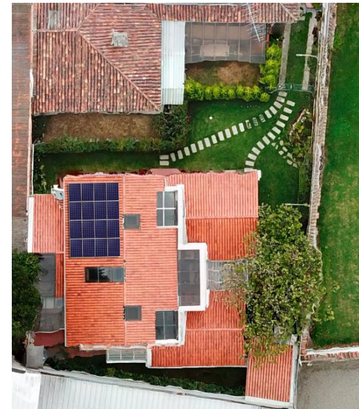
Figura 4-51 Vista área de módulos PV con un sistema de anclaje coplanar
