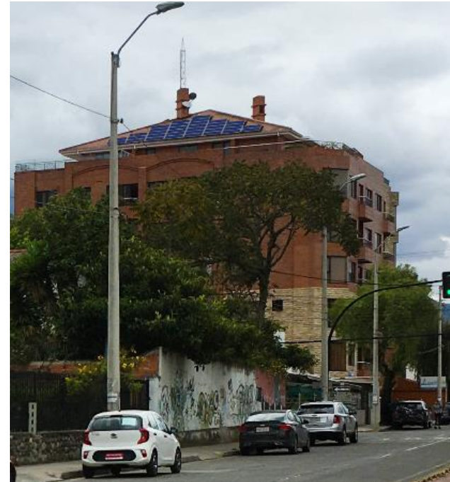
Figura 4-88 Vista de paneles PV, desde la calle, predio 008, tramo E
