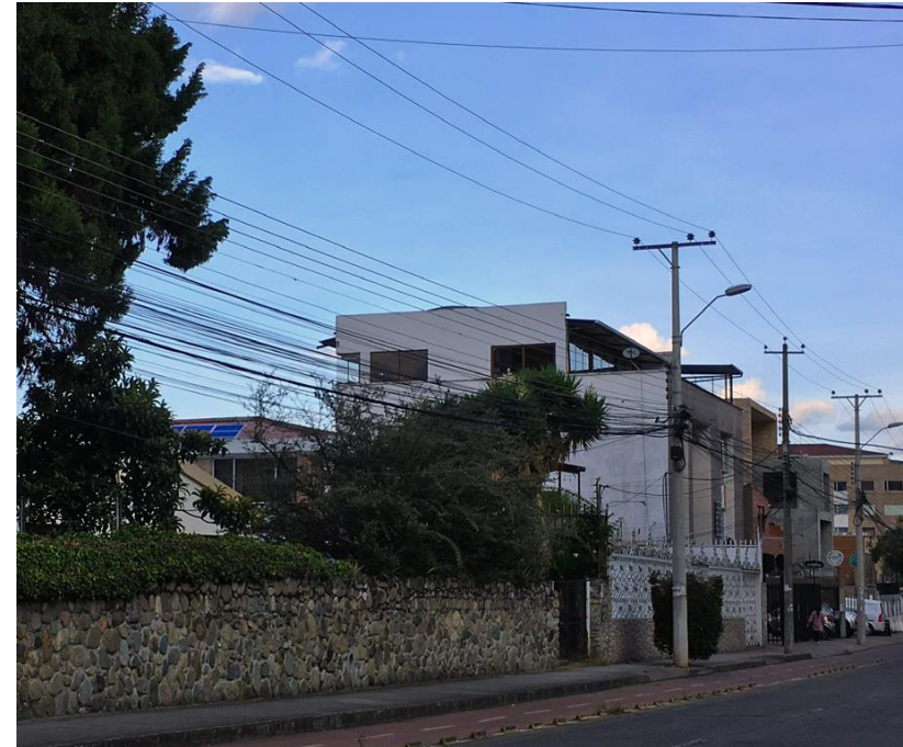
Figura 4-84 Vista de paneles PV, desde la calle, predio 002, tramo B
