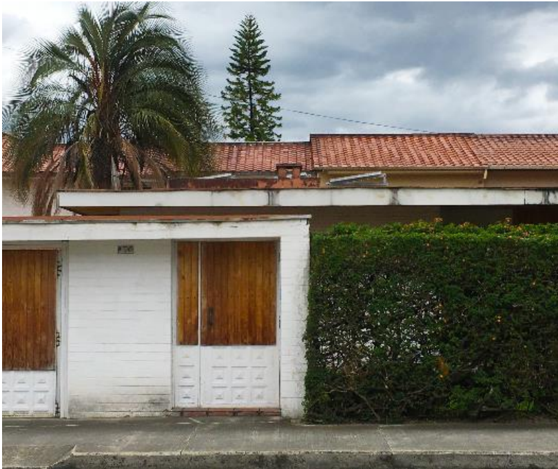
Figura 4-87 Vista de paneles PV, desde la calle, predio 005, tramo E
