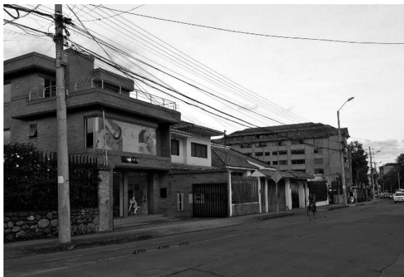
Figura 4-72 Cubiertas visibles con PV, tramo A (parte 2)
