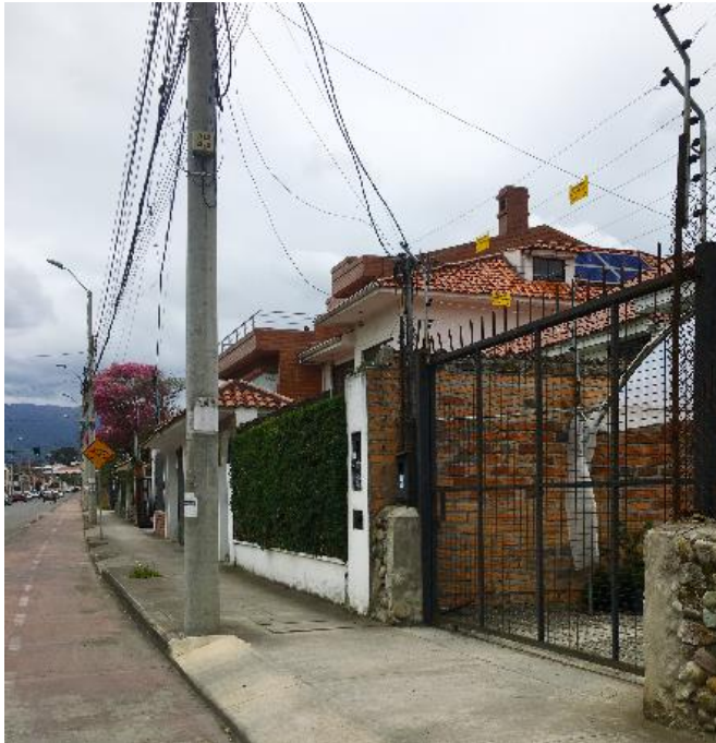
Figura 4-83 Vista de paneles PV, desde la calle, predio 003, tramo A
