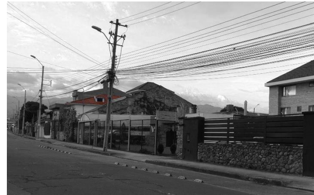
Figura 4-73 Cubiertas visibles con PV, tramo A (parte 3)
