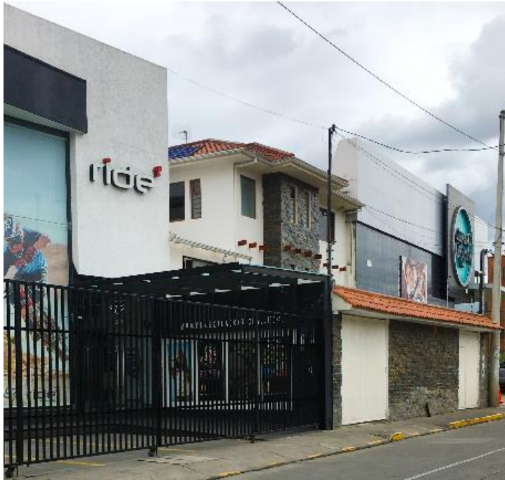
Figura 4-85 Vista de paneles PV, desde la calle, predio 001, tramo C
